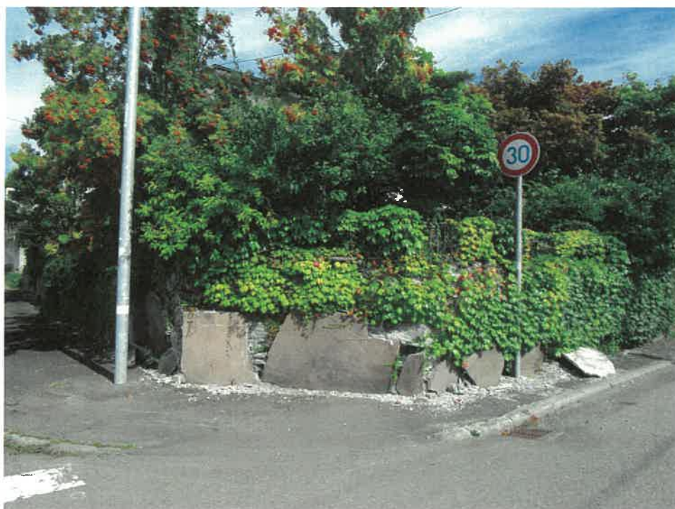
西側のコンクリート製土留の状況
