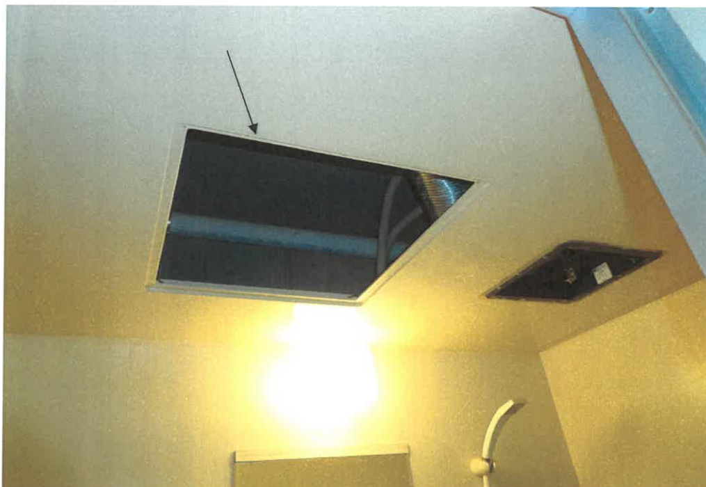
浴室の点検口の状況
