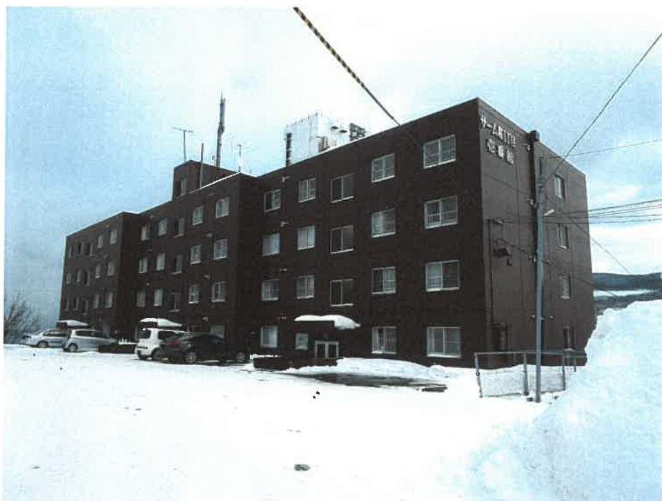
全景(西側から撮影)
