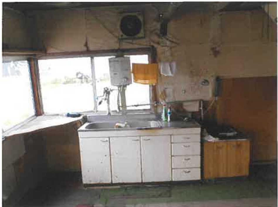
物件 5 事務室内の流し
