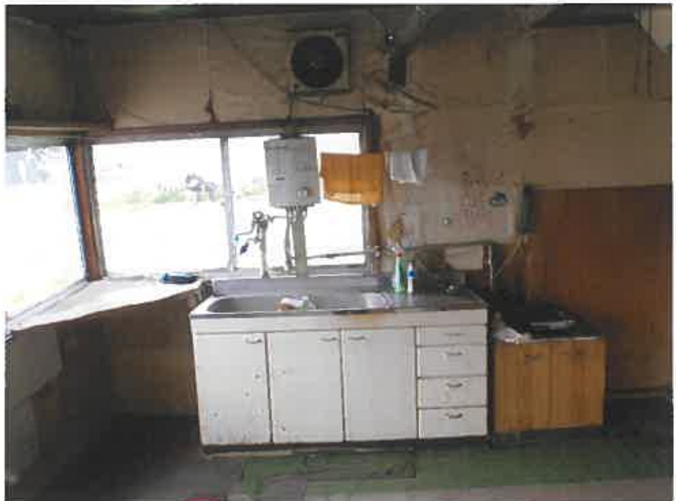
物件 5 事務室内の流し
