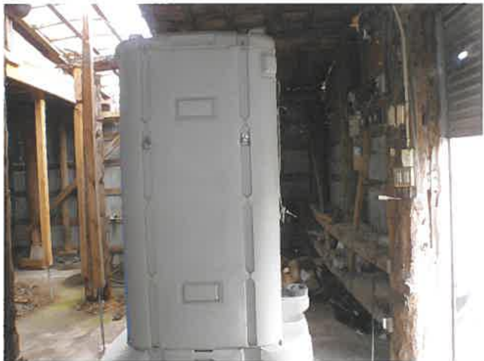
物件 2 1 階作業場
