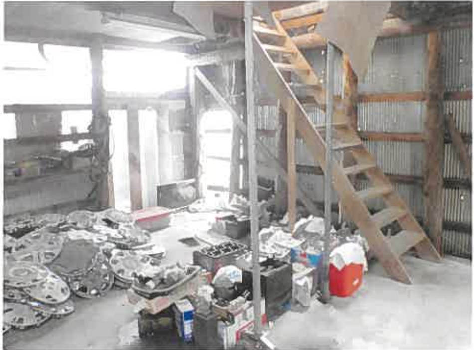
物件 2 1階作業場
