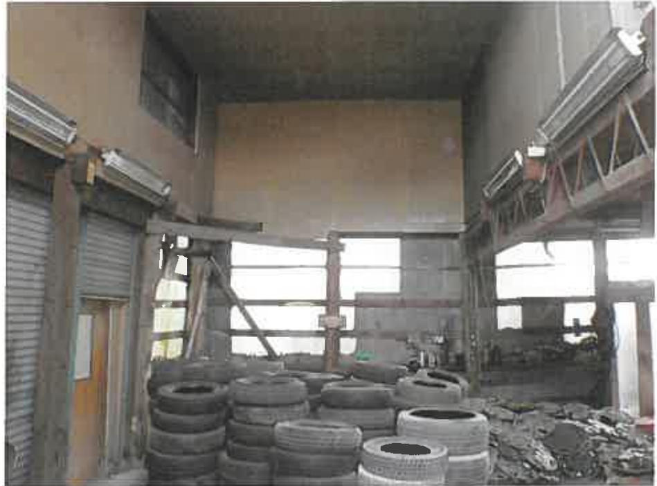
物件 2 1 階作業場
