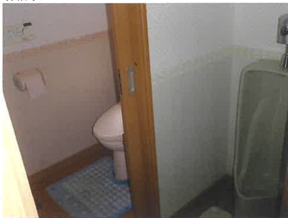
物件 2 1階トイレ
