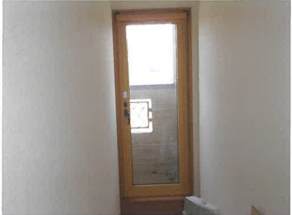
物件 2 2階ホールからベランダ方向
