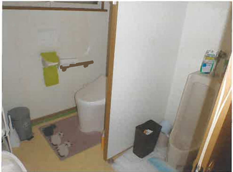
物件 3 2 階トイレ
