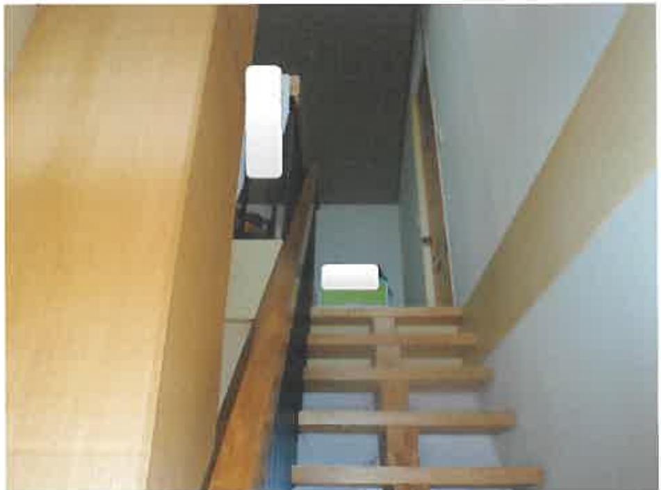
物件2 階段（1階から2階方向）
