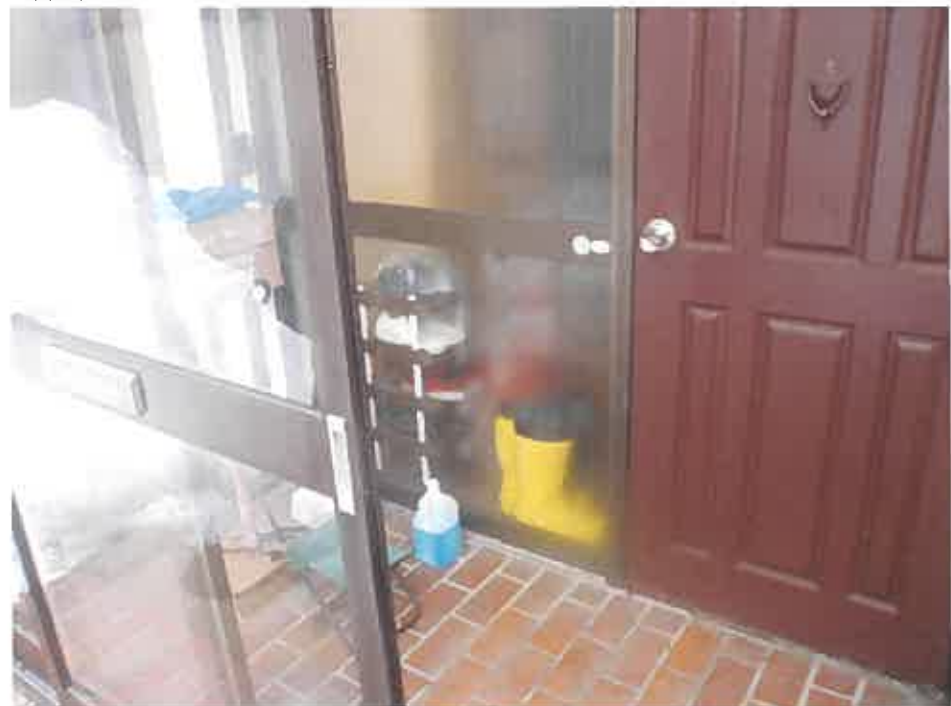
物件 2 玄関風除室
