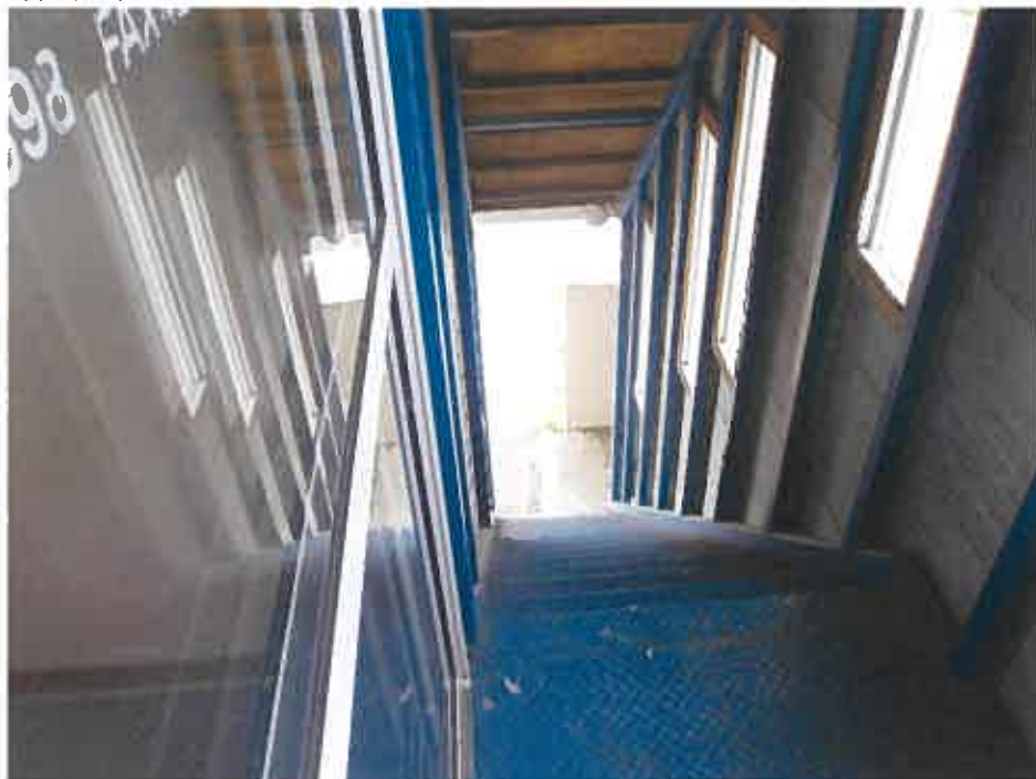
物件3 事務室脇の外階段
