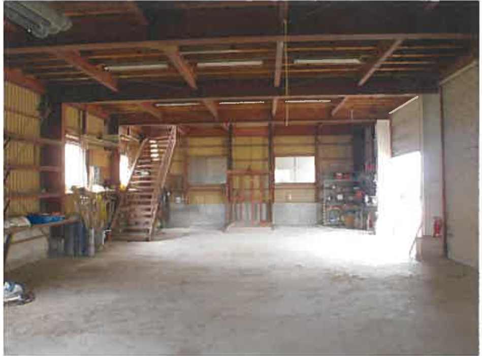
物件 5 1 階作業場
