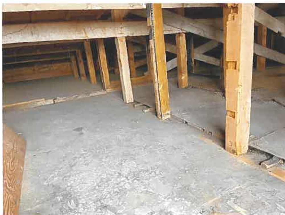
物件2 2階屋根裏部分
