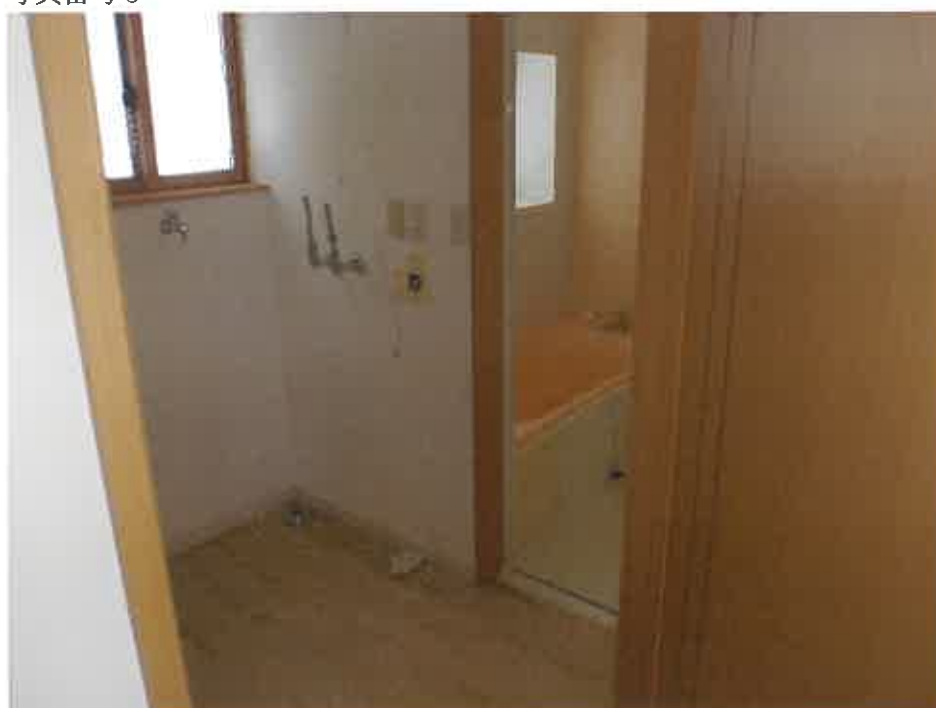
物件2 ボイラー跡
