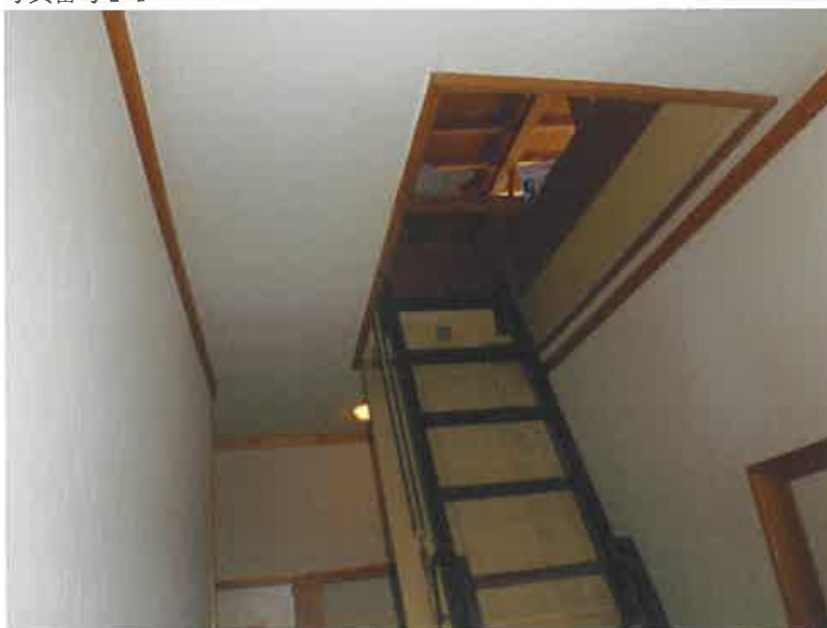
物件3 2階から3階部分へ至る収納梯子
