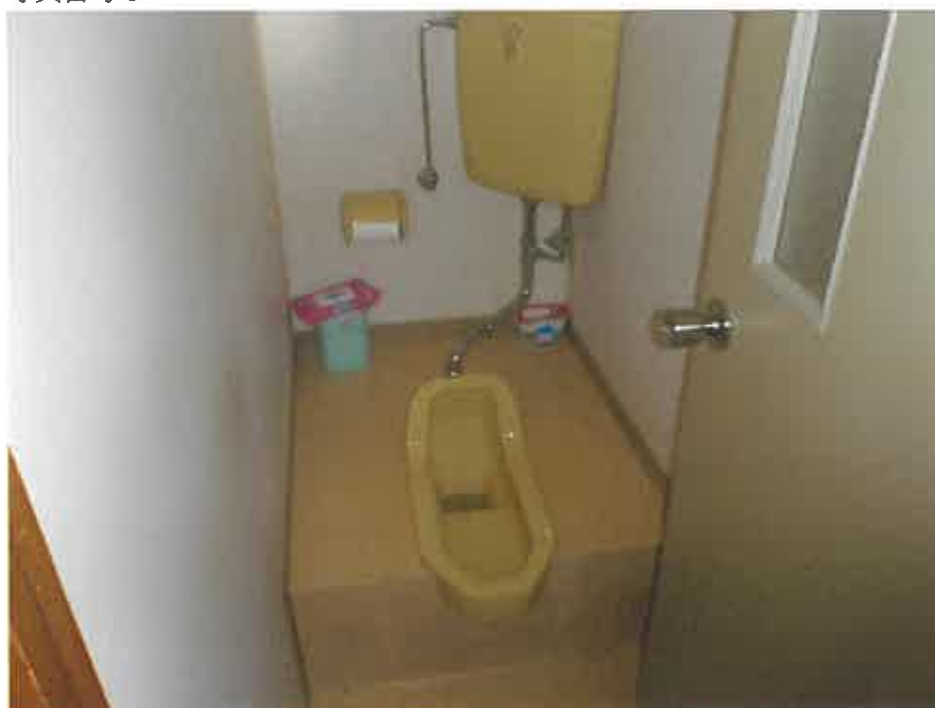
物件3 1階トイレ
