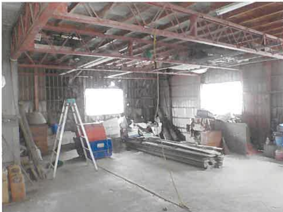
物件3 車庫 (増築部分)
