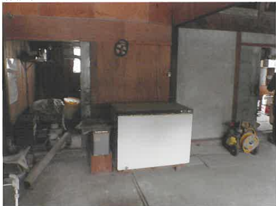
物件 2 倉庫 (南東部)
