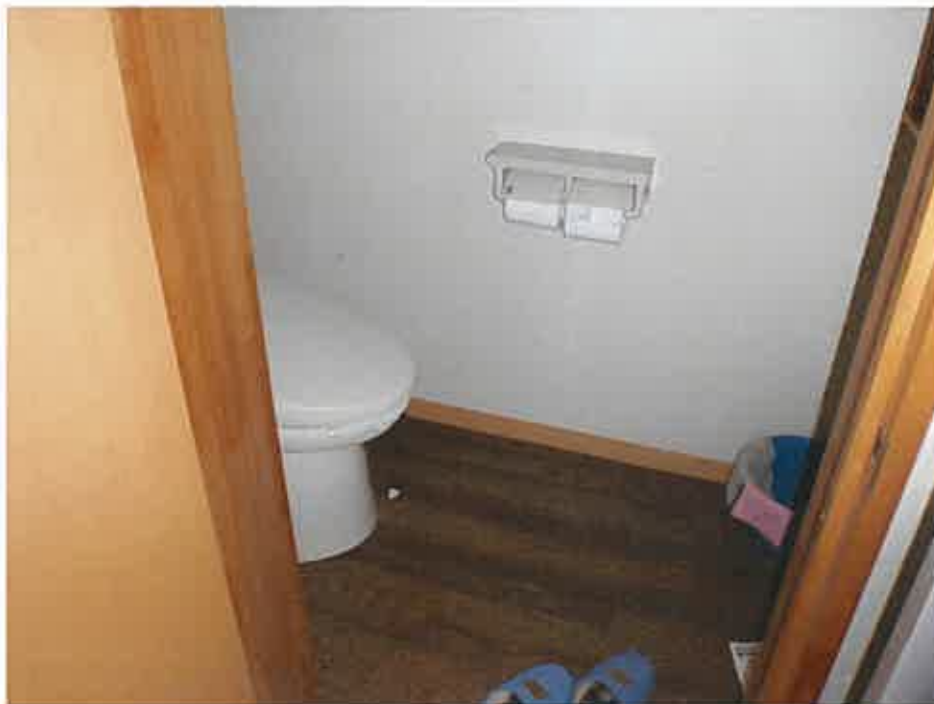
物件3未登記附属建物 トイレ
