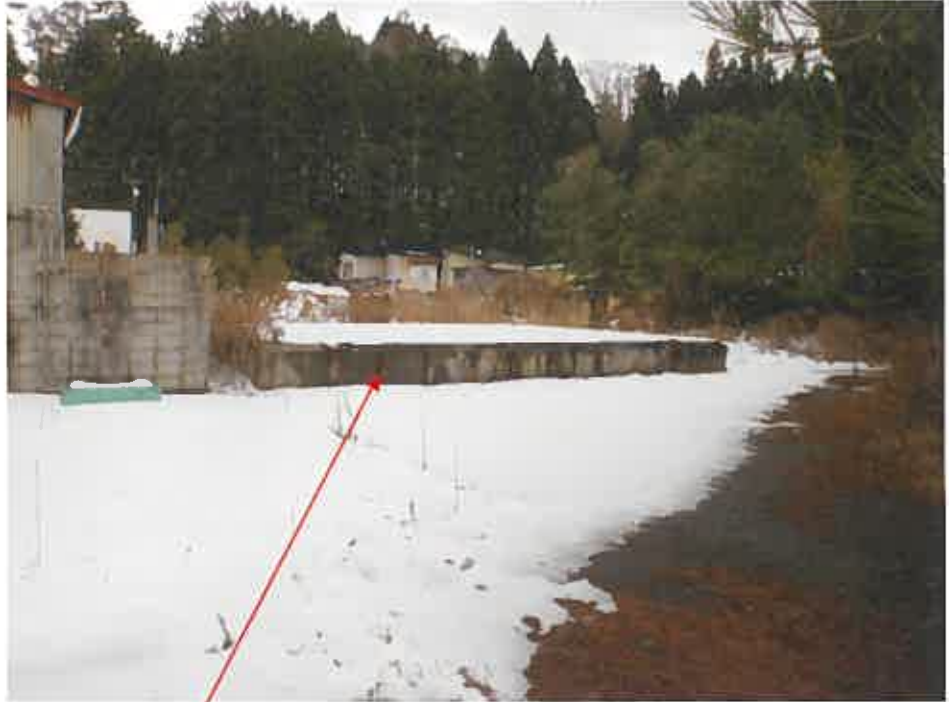
物件4上に基礎部分のみが残る物件8附属建物符号2
