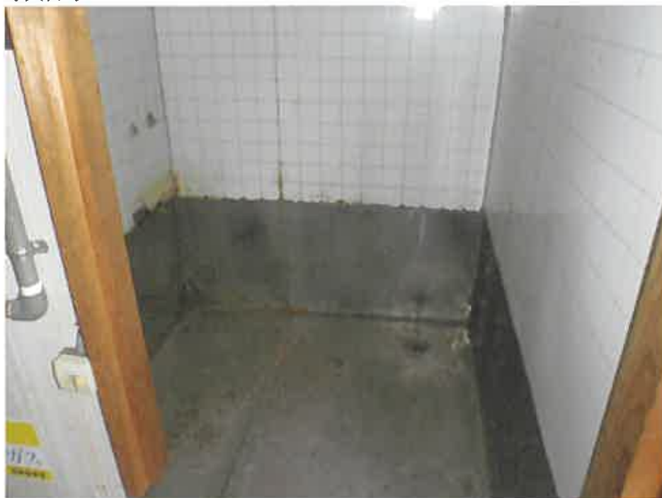
物件8 2階浴室(跡)
