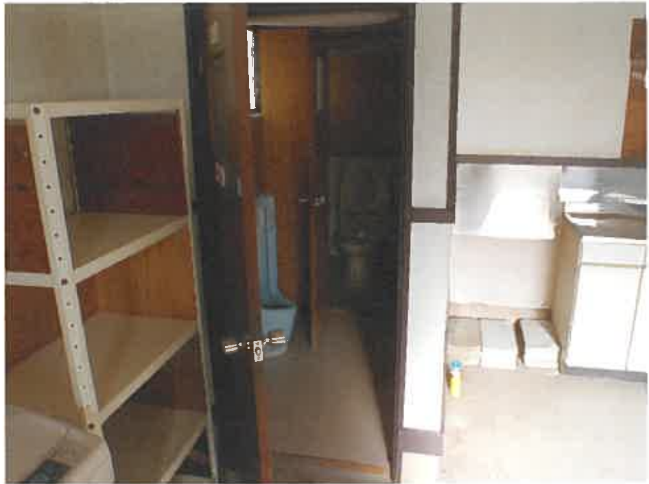
物件8 1階トイレと流し
