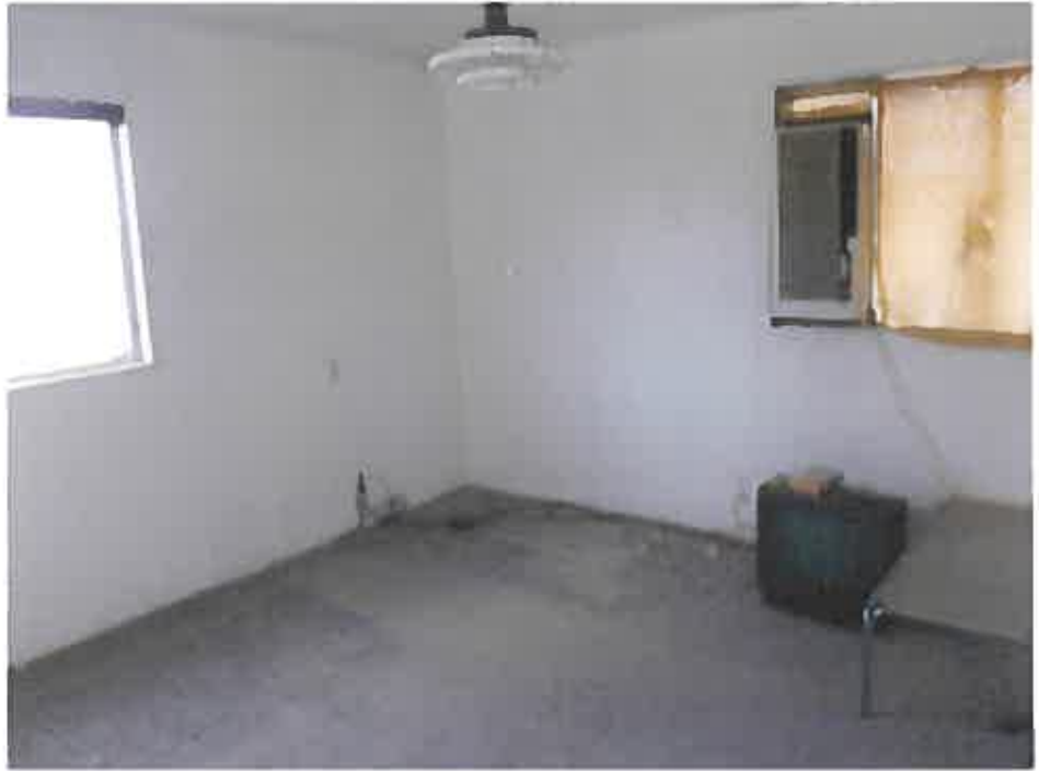
物件 8 2階和室 (北東側)
