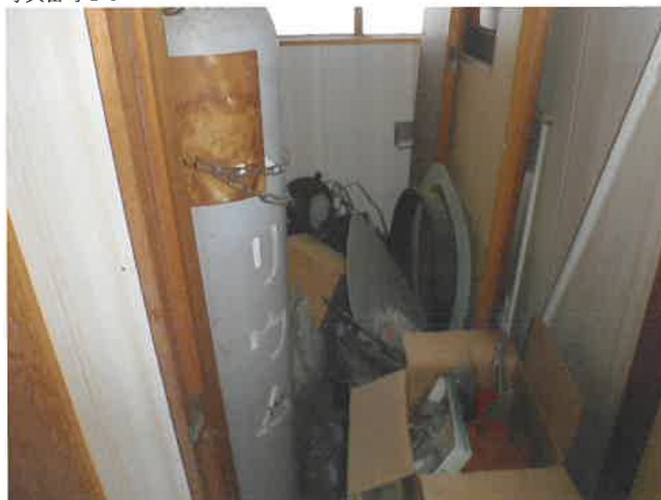
物件8 2階トイレ
