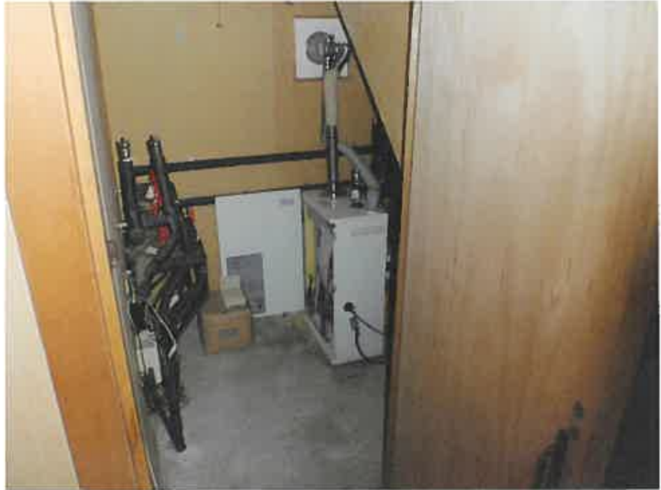
物件10 ボイラー室 (東側)
