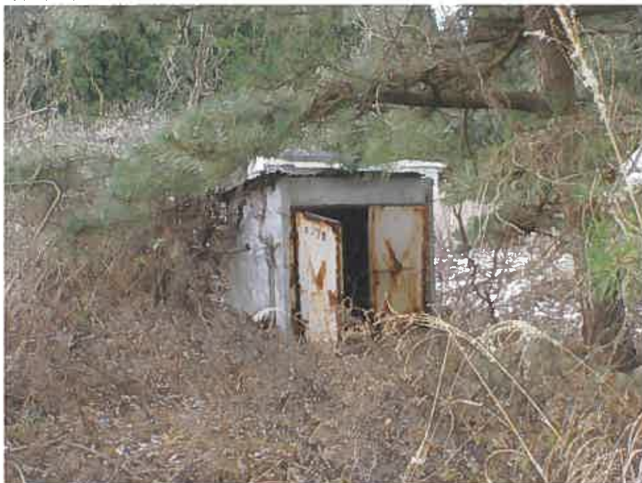
物件4上の工作物（ポンプ小屋）
