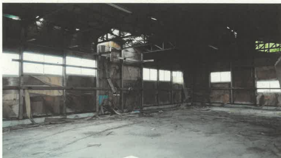
物件 9 附属建物符号 2 内部の状況
