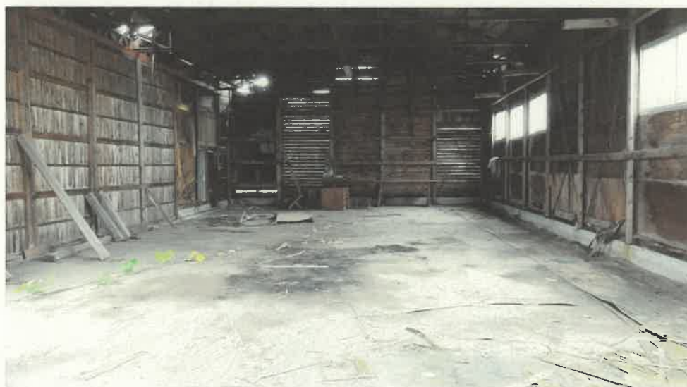
物件 9 附属建物符号 1 内部の状況
