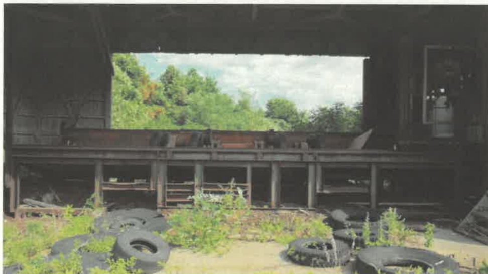
物件 1 2 附属建物符号 4 内部の状況
