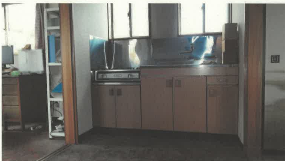
物件 1 2 附属建物符号 1 内部の状況 (2 階)
