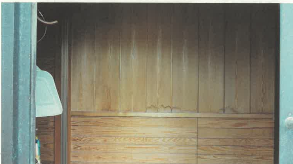
物件12附属建物符号1内部の状況（1階）
