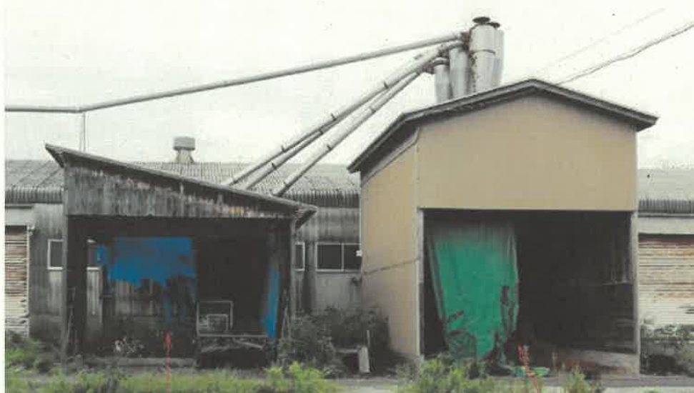
物件 1 2 附属建物符号 2 内部の状況
