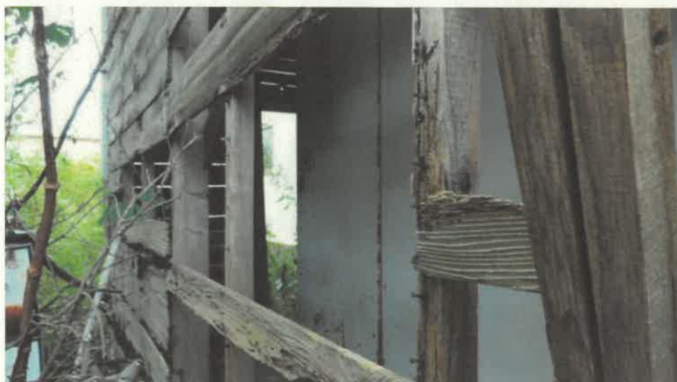
物件 1 2 附属建物符号 3 内部の状況
