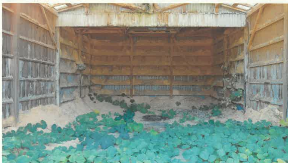
物件 2 附属建物符号 1 内部の状況（1 階）
