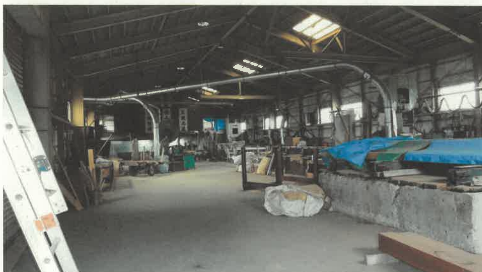
物件 1 2 主である建物内部の状況（1 階）
