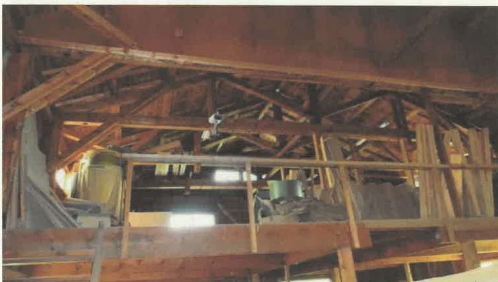
物件 1 2 附属建物符号 5 内部の状況（2 階）
