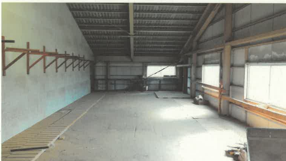
物件12主である建物内部の状況（2階）
