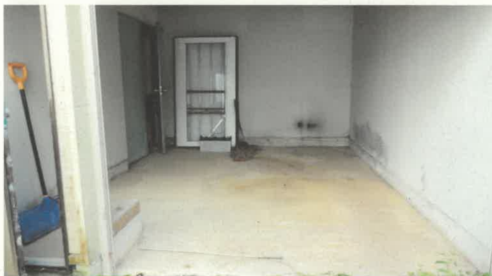
物件 4 附属建物符号 1 内部の状況
