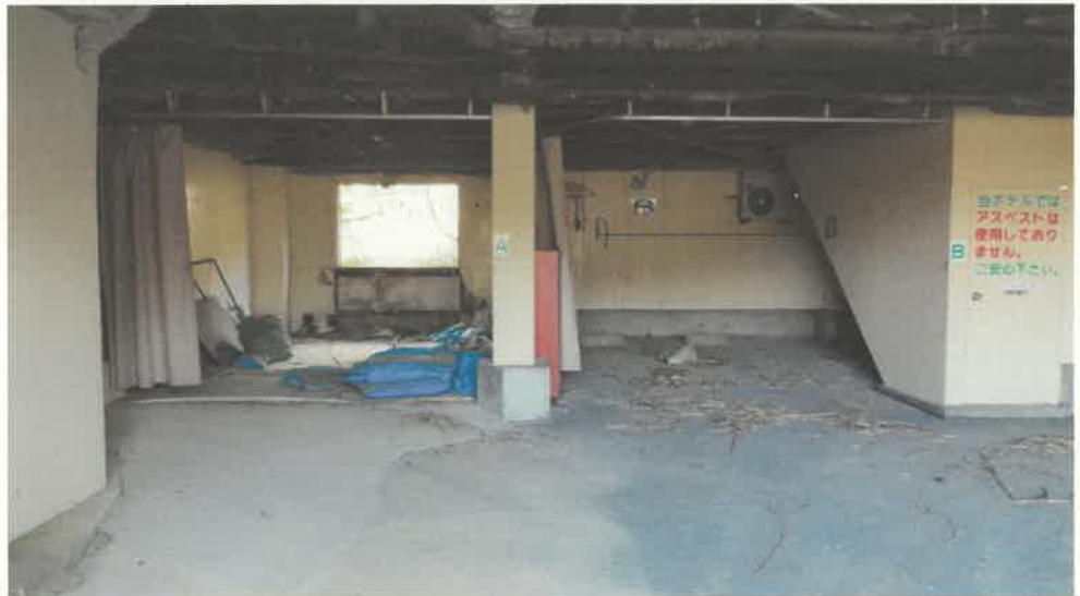
物件 4 主である建物内部の状況（1 階）
