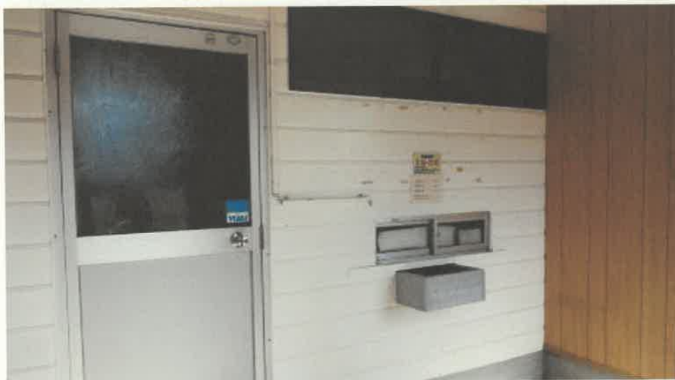
物件 2 未登記附属建物 1 内部の状況
