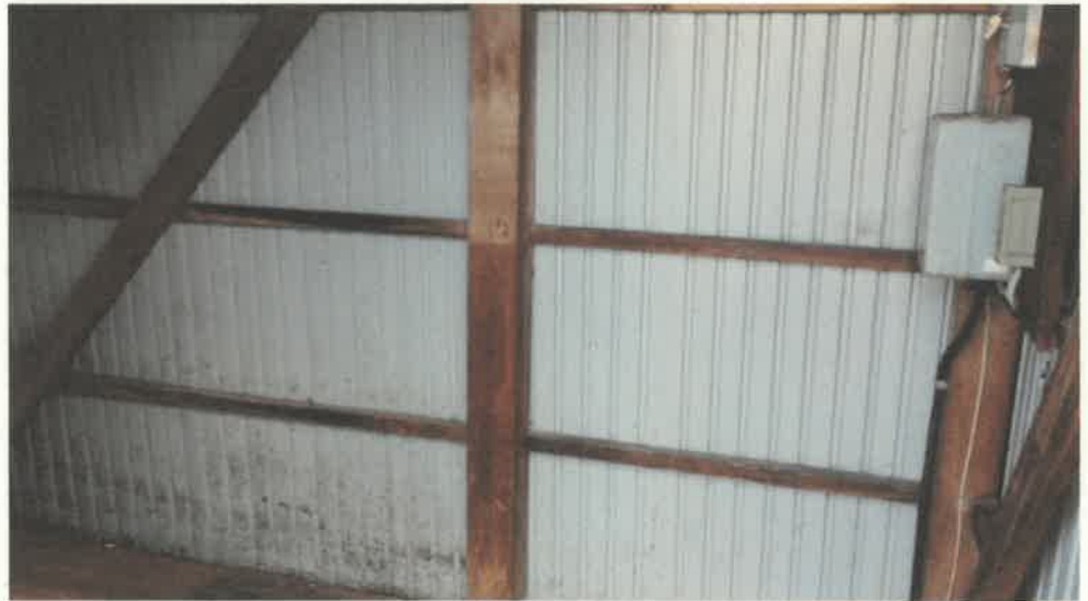
物件 2 未登記附属建物 2 内部の状況
