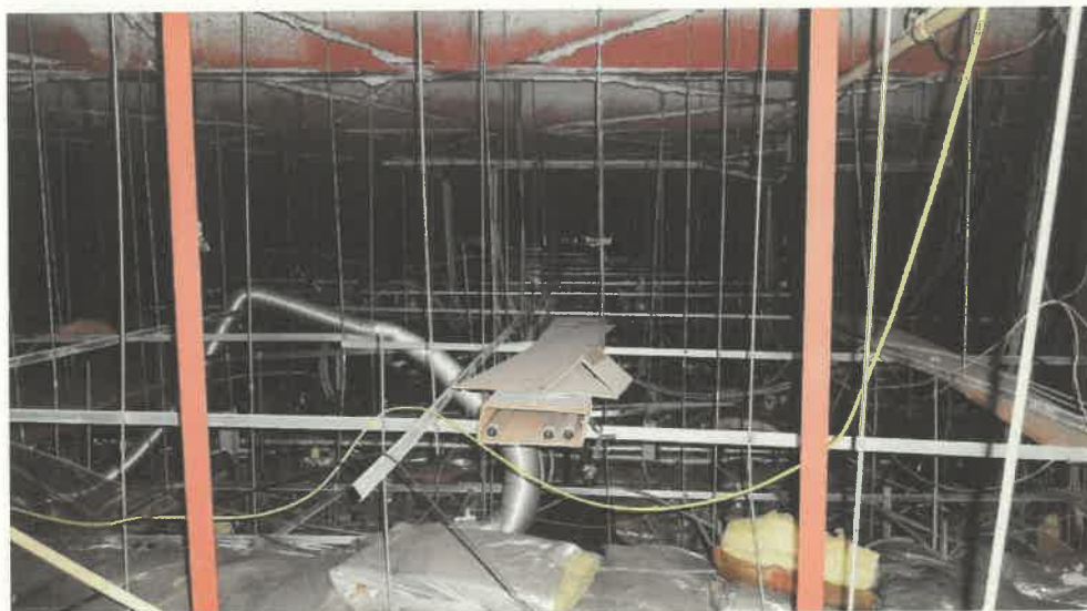
物件 2 主である建物内部の状況（1 階天井裏）
