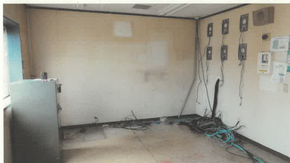
物件 2 主である建物内部の状況（2 階）
