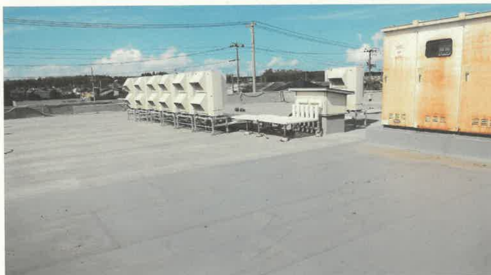
物件 2 主である建物内部の状況（屋上）
