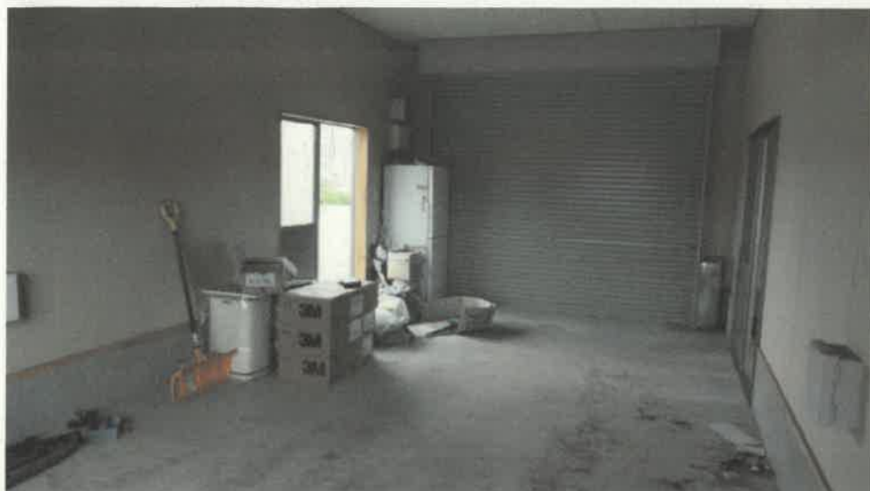
物件 2 附属建物符号 1 内部の状況
