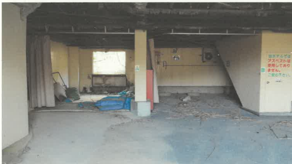
物件 4 主である建物内部の状況（1 階）
