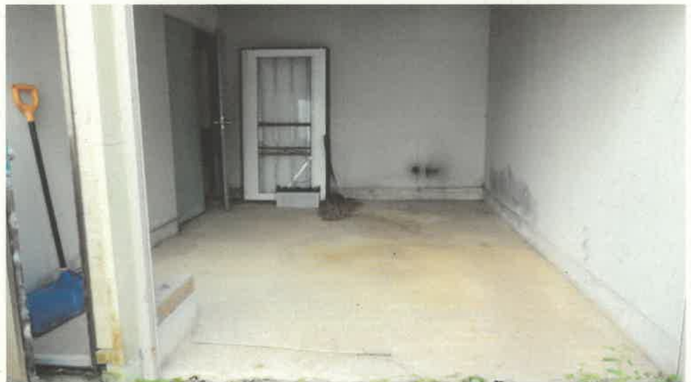
物件 4 附属建物符号 1 内部の状況
