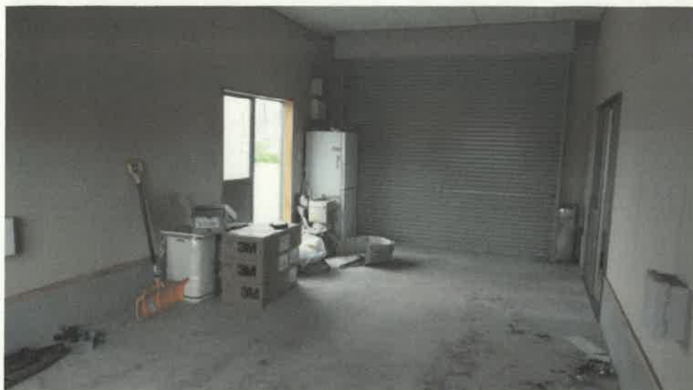
物件 2 附属建物符号 1 内部の状況
