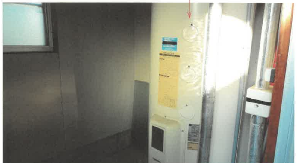
物件 7 未登記附属建物内部の状況
