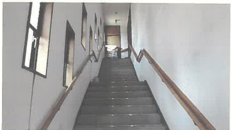
物件2建物内部の状況（2階）
