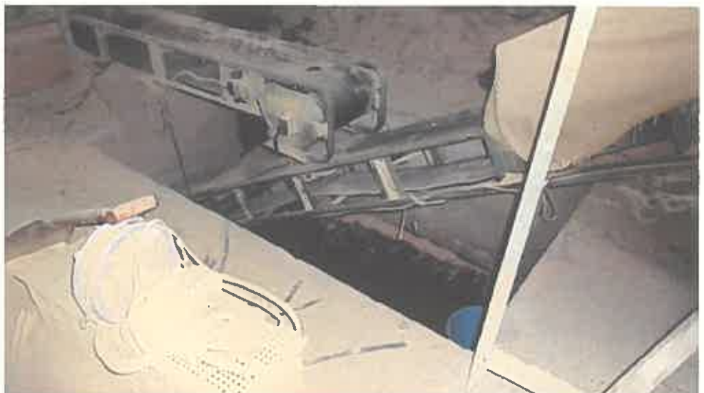
前同 (床が一部掘り下げられている)
