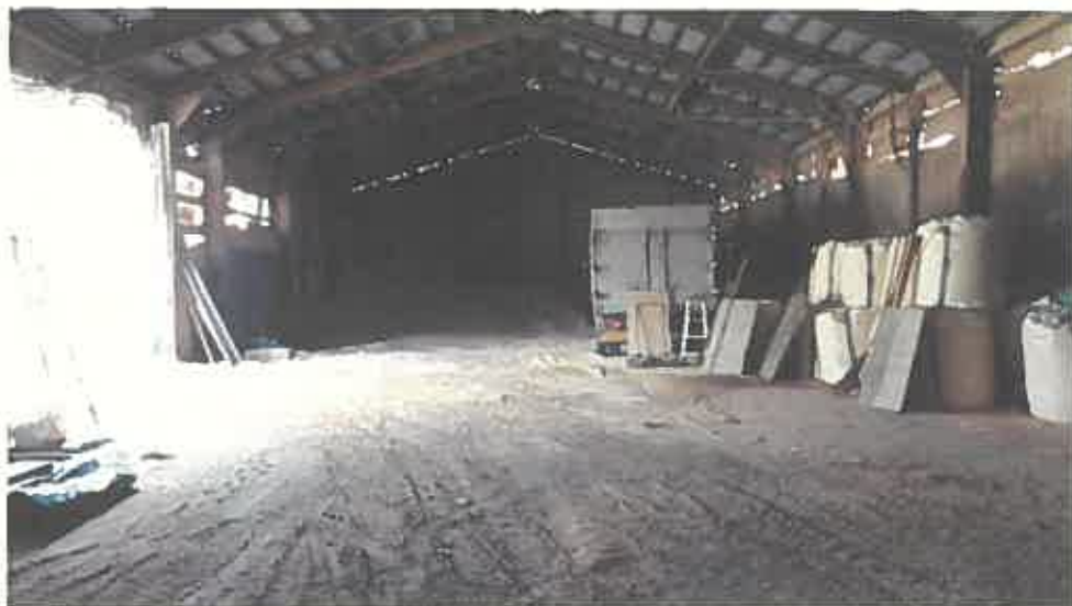
物件 5 主である建物内部の状況
