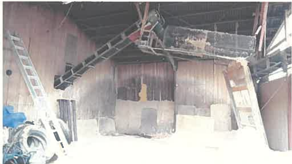
物件4建物内部の状況
