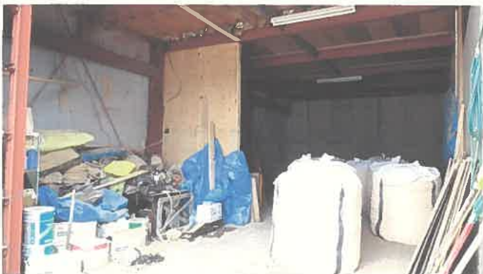
物件 5 未登記附属建物内部の状況 (1 階)
