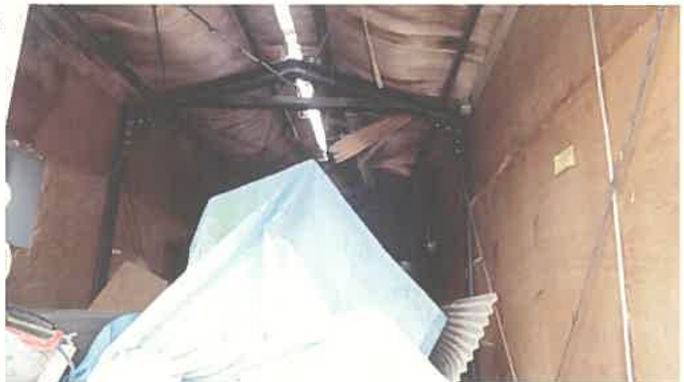
物件12未登記附属建物1内部の状況
