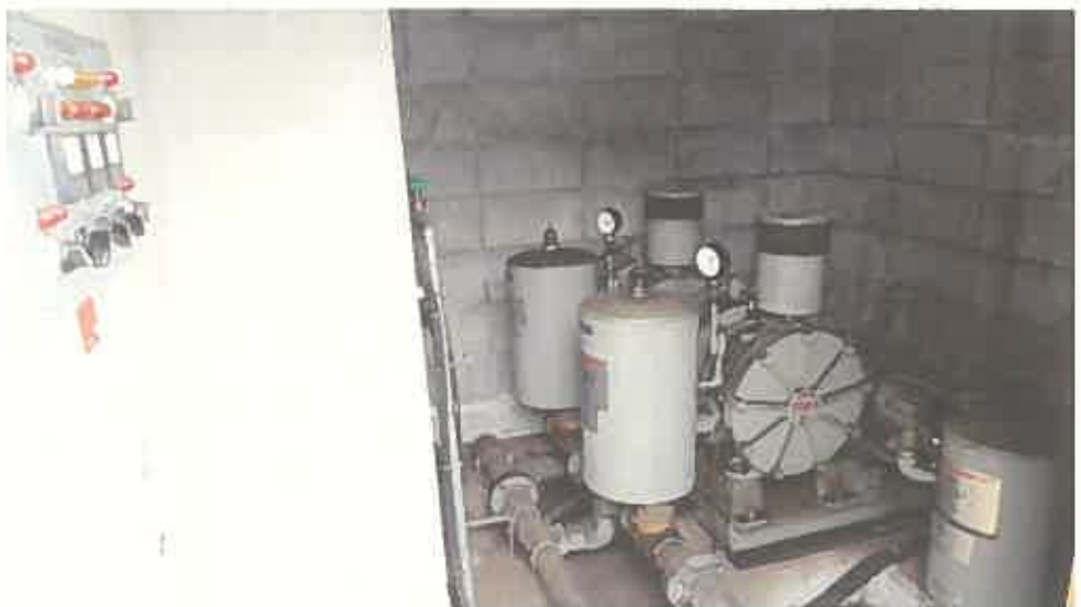
物件16未登記附属建物2内部の状況
