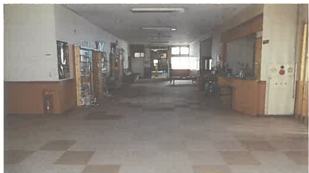
物件 1、2 主である建物内部の状況 (1 階)
