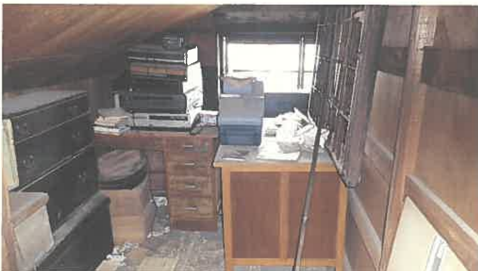
物件 2 建物内部の状況（2 階）
