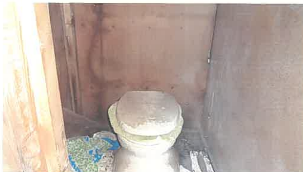
物件 2 建物内部の状況 (1 階)
