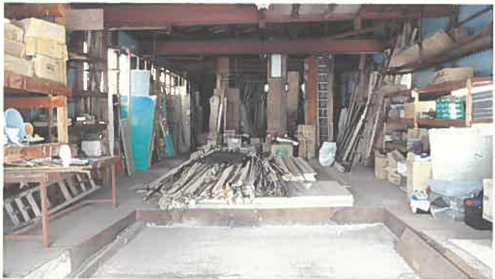
物件 3 主である建物内部の状況
