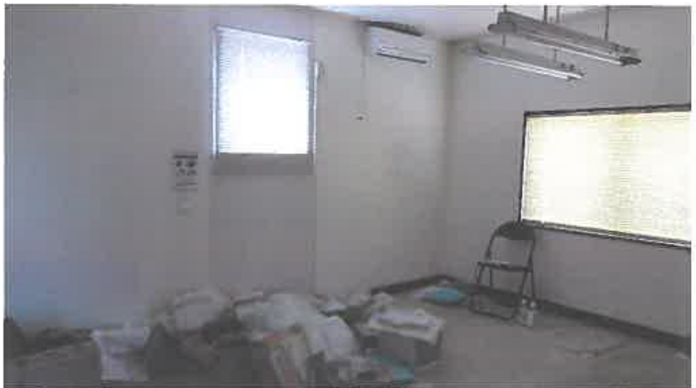
物件4建物内部の状況（2階）
