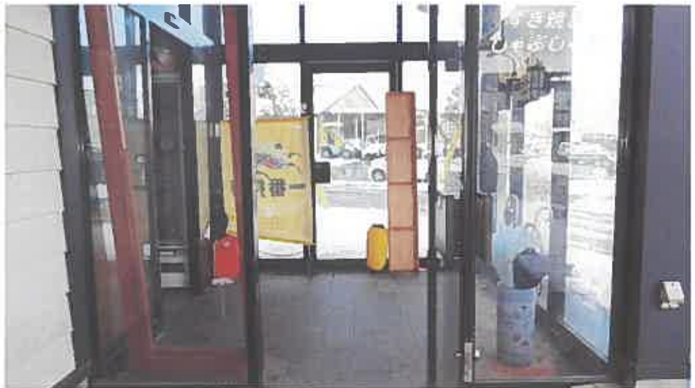
物件 2 建物内部の状況 (1 階)
