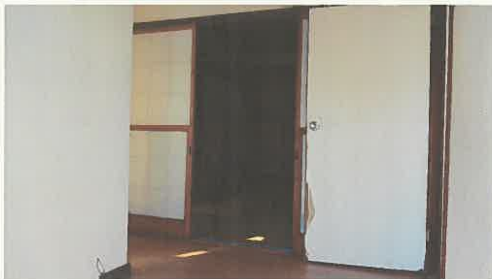
物件 2 建物内部の状況（1 階）
