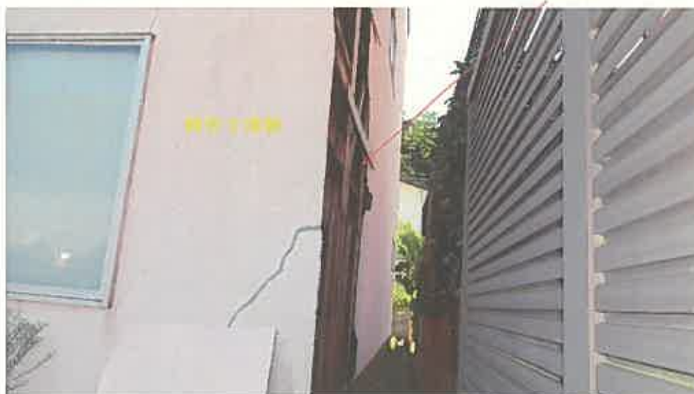
外壁が一部崩落している
