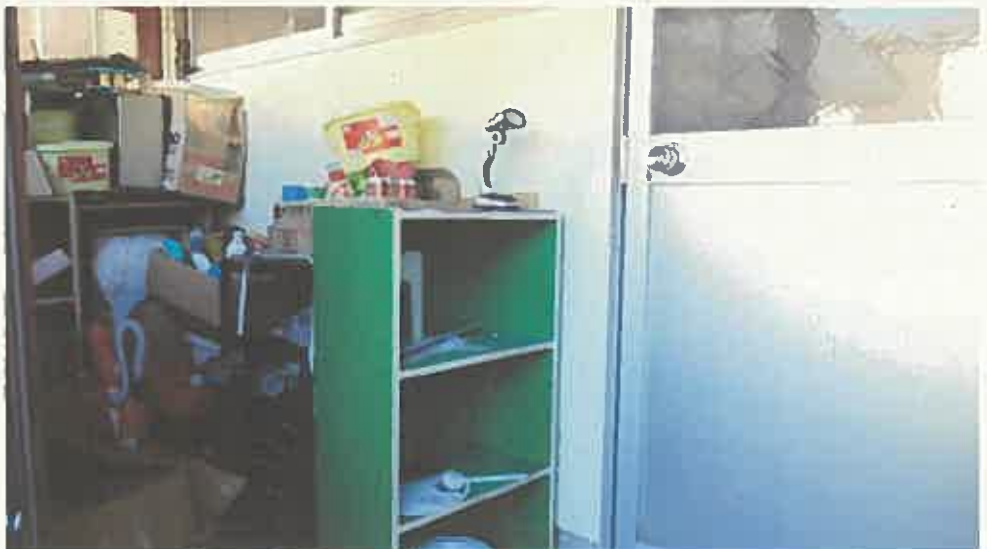
下屋内部の状況
