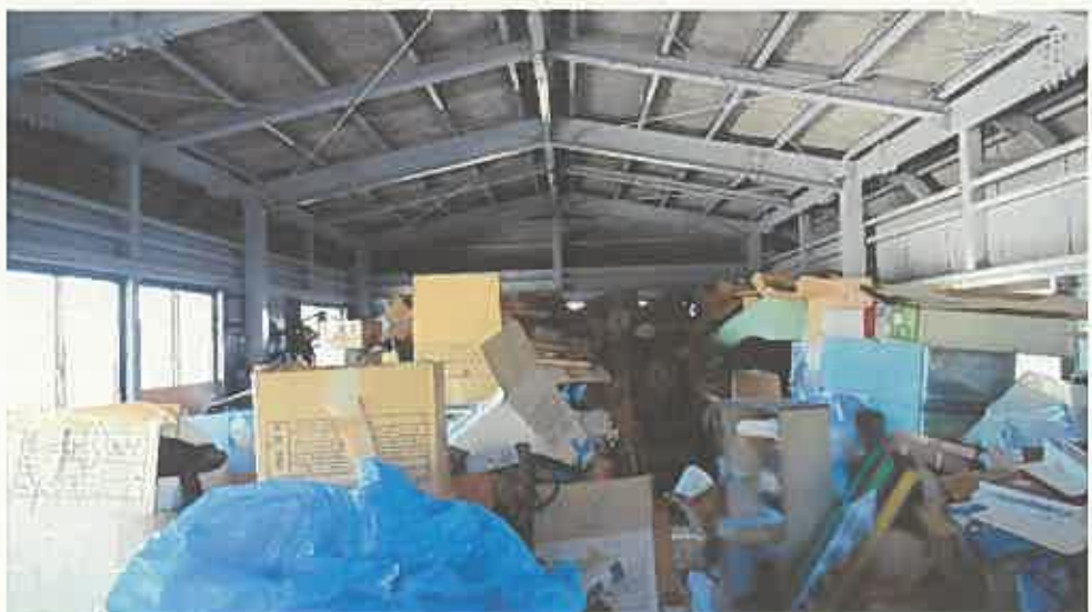
物件 5 建物内部の状況 (3 階)
