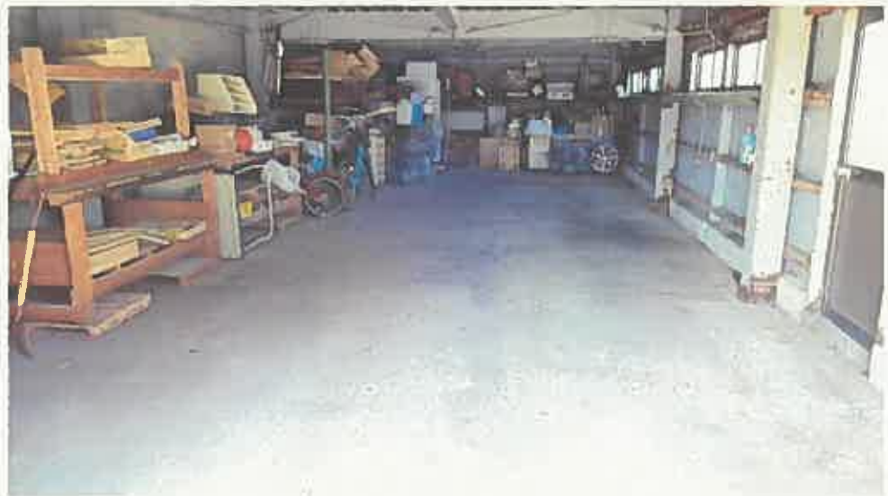
物件5建物内部の状況（1階）
