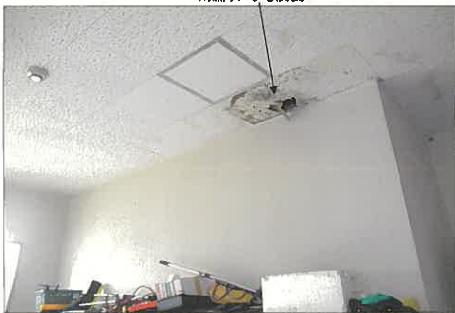
雨漏りによる腐食
