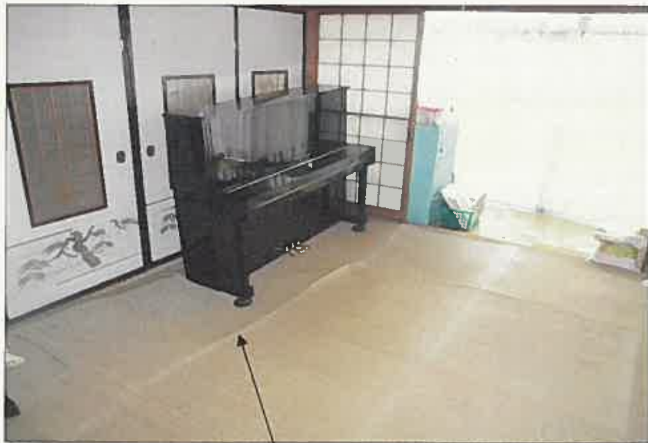
床が大きく沈み込んでいる
