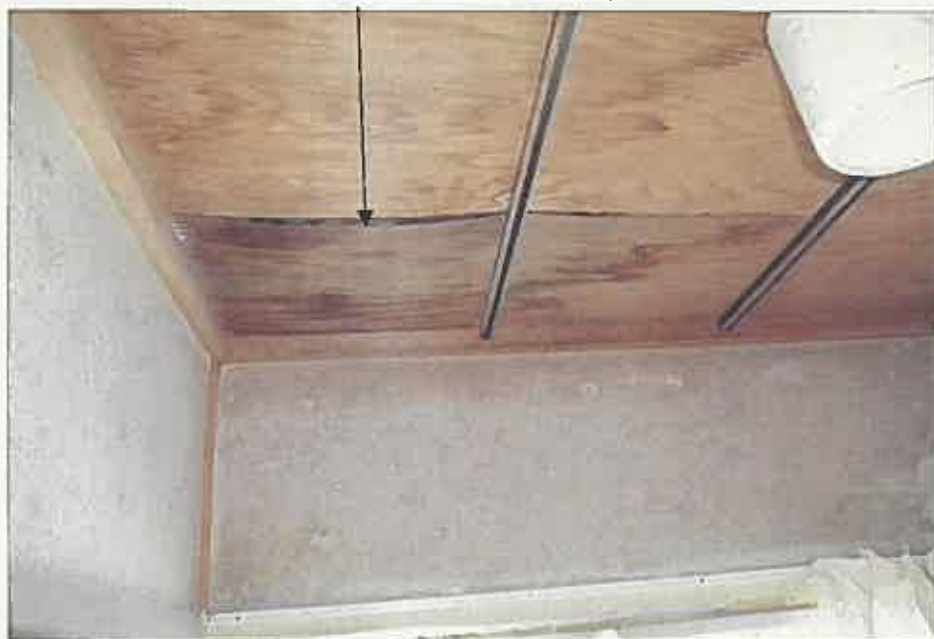
天井の腐食(雨漏りの発生)
