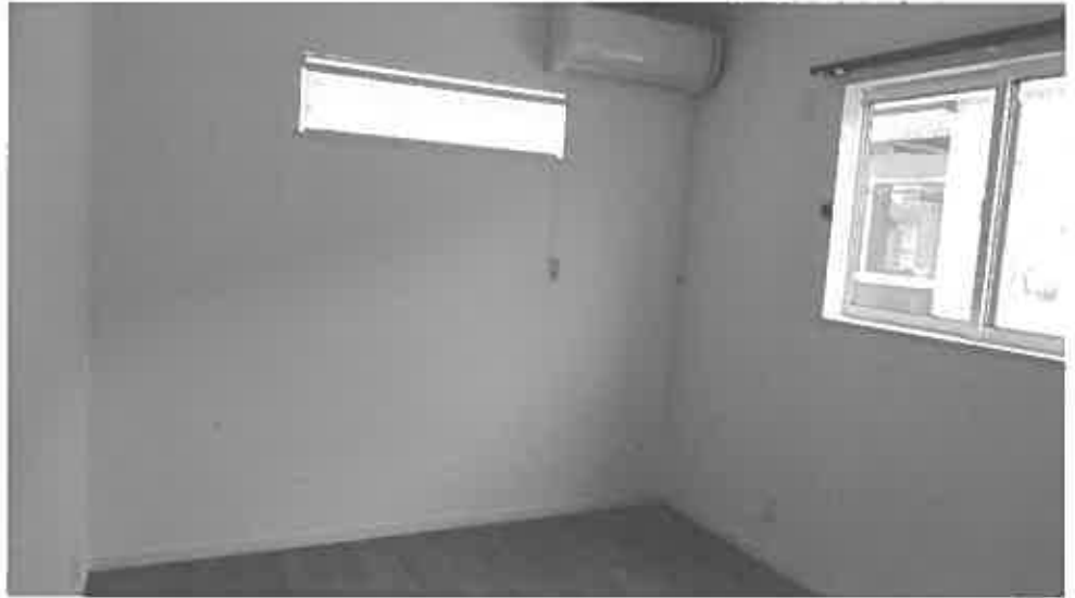
物件 3 建物内部の状況 (2 階)
