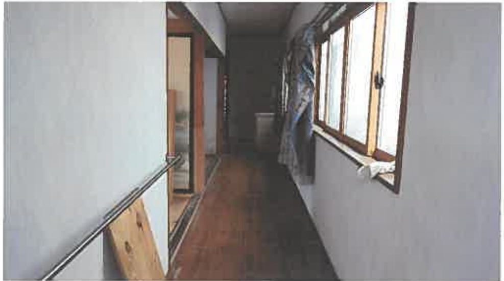
物件 1 建物内部の状況 (1 階)
