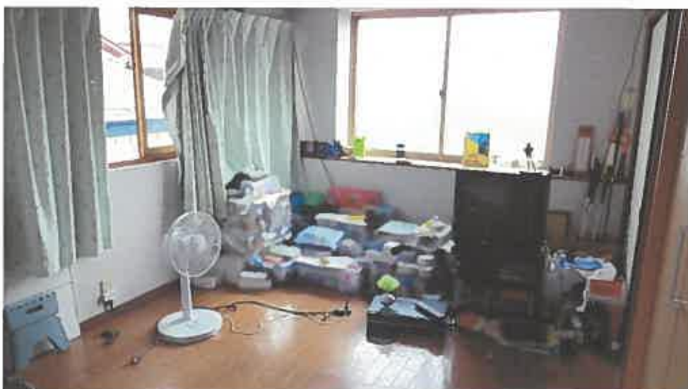
物件 1 建物内部の状況 (2 階)
