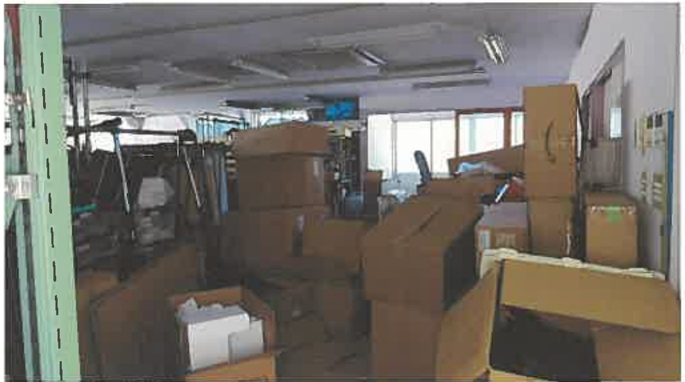
物件 6 主である建物内部の状況
