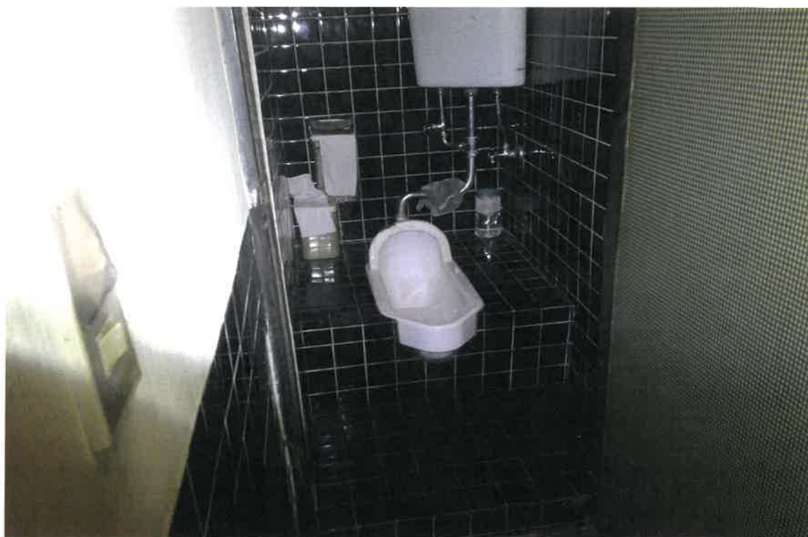
写真⑱(物件4 1階 店舗トイレ)
