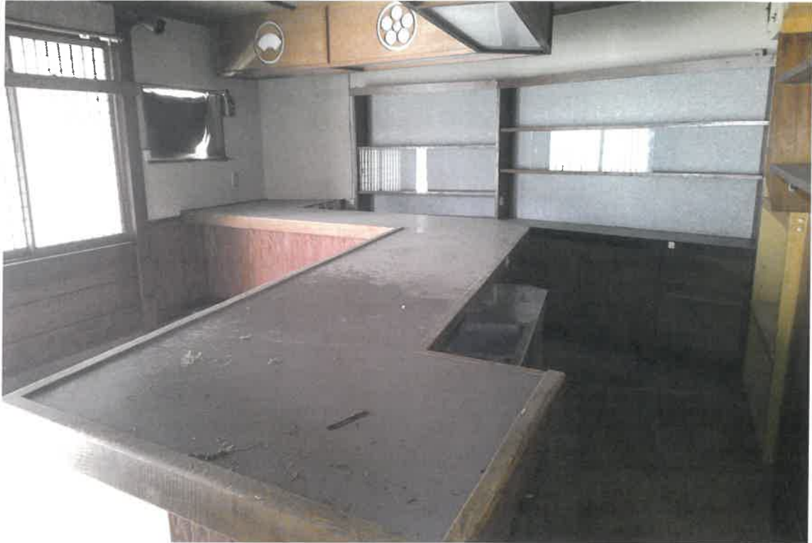
写真⑤(物件2 1階 店舗厨房)
