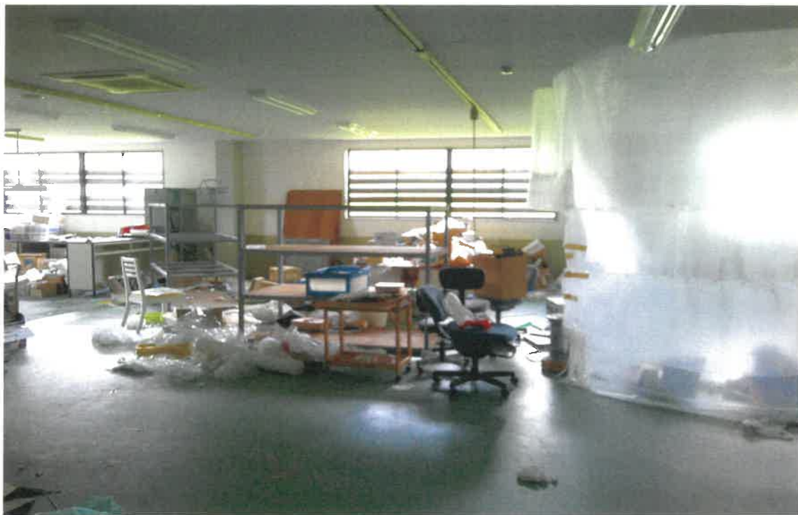
写真⑦(物件4 2階 工場内部②)
