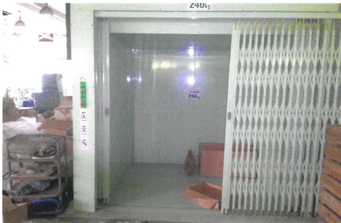
写真⑤(物件4 1階 エレベーター前 )
