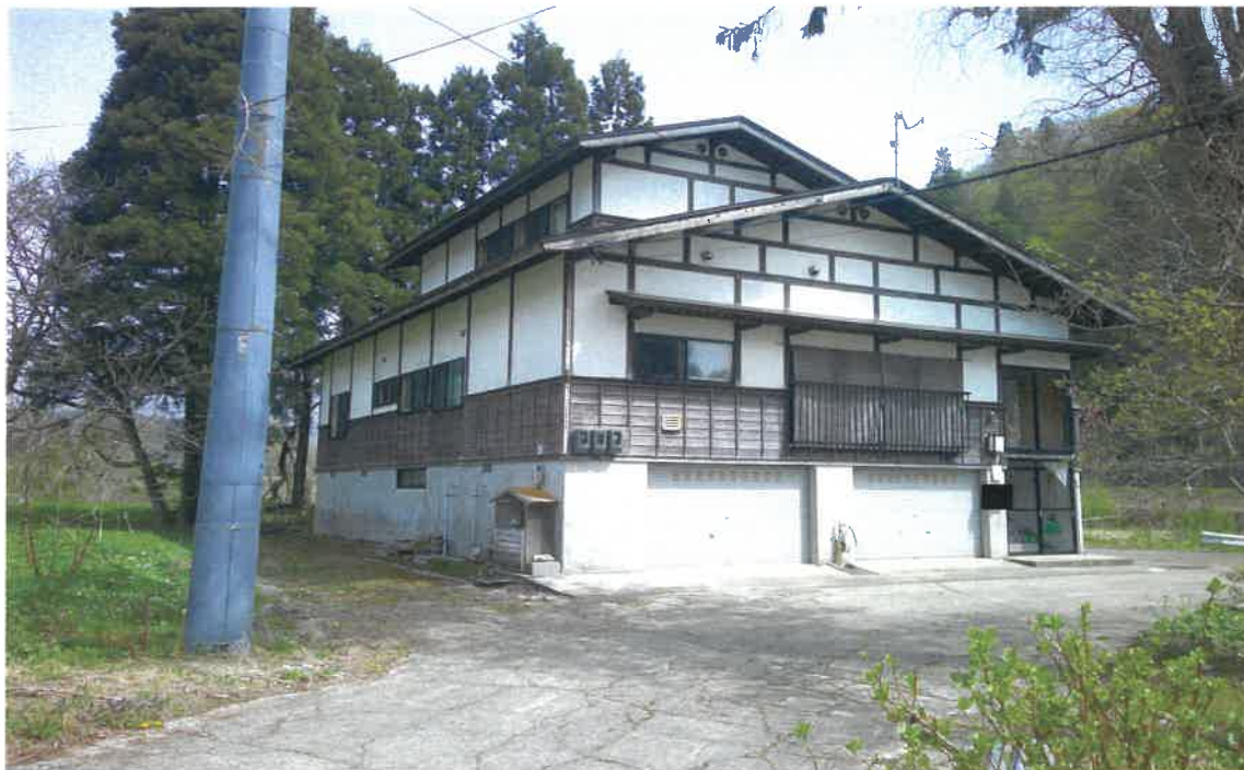
写真① (建物外観)
