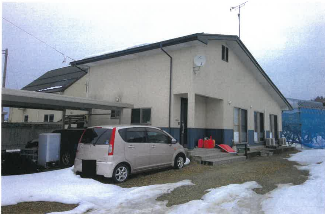
写真① (建物外観)
