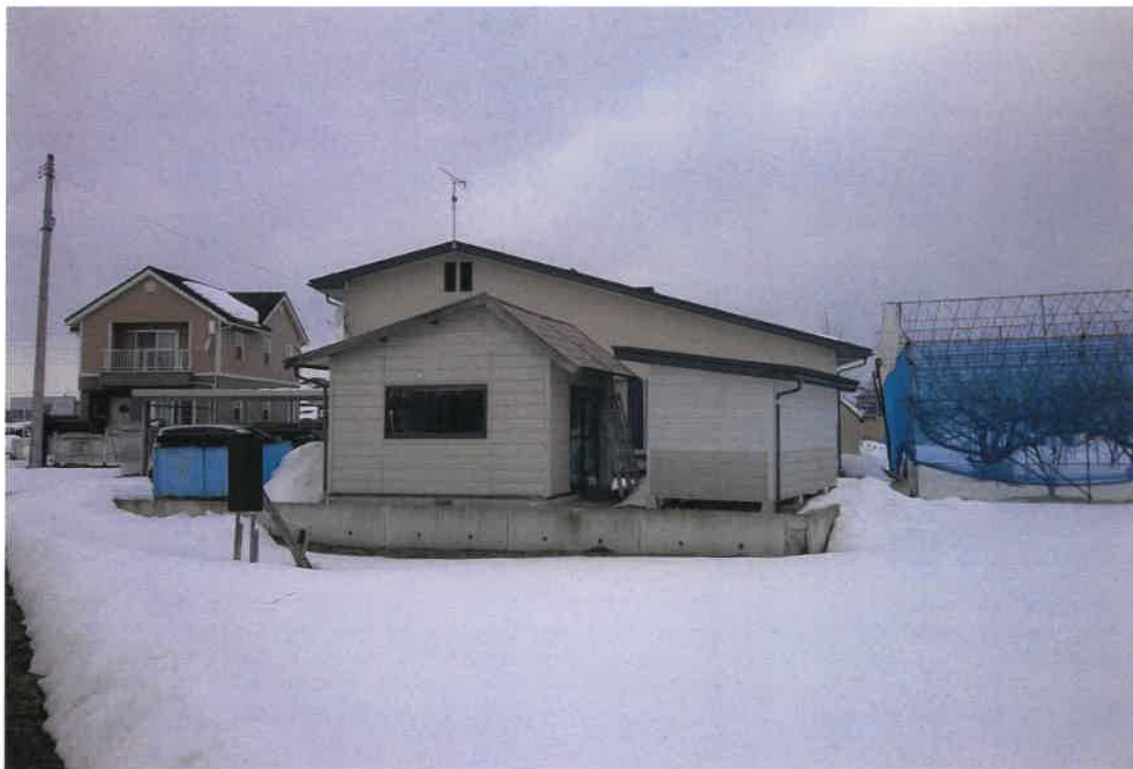
写真② (物件2の建物の附属建物)
