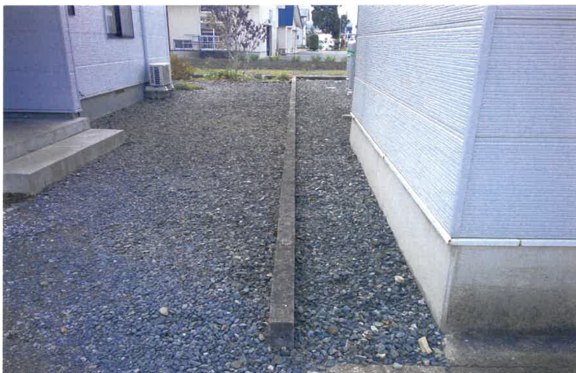
写真② (物件1 東側隣地との境界付近)
