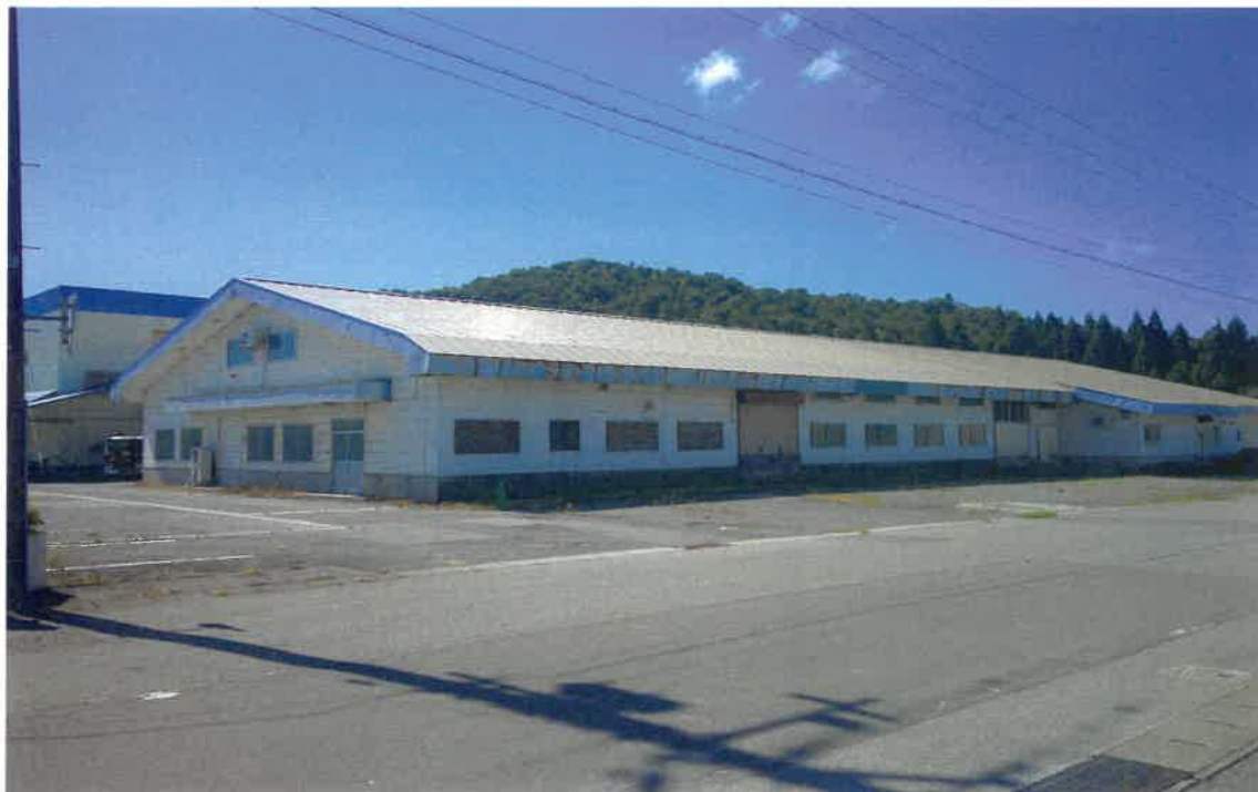
写真①(物件2 工場外観)
