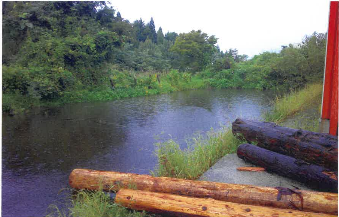
写真⑦(物件1西側池)
