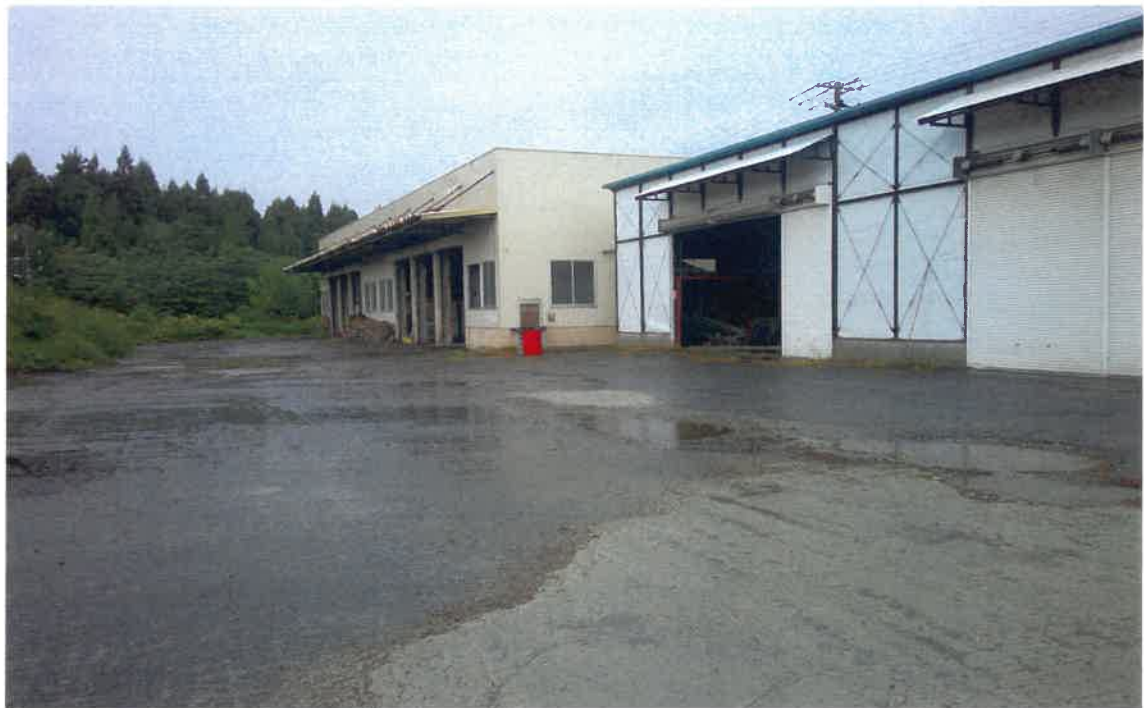
写真⑧(物件3 作業場及び附属建物倉庫外観)
