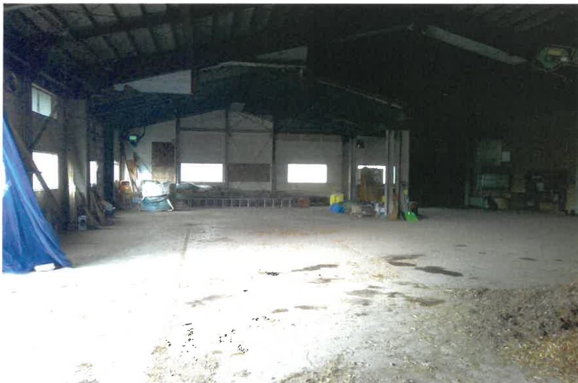
写真③ (物件 2 工場内部②)
