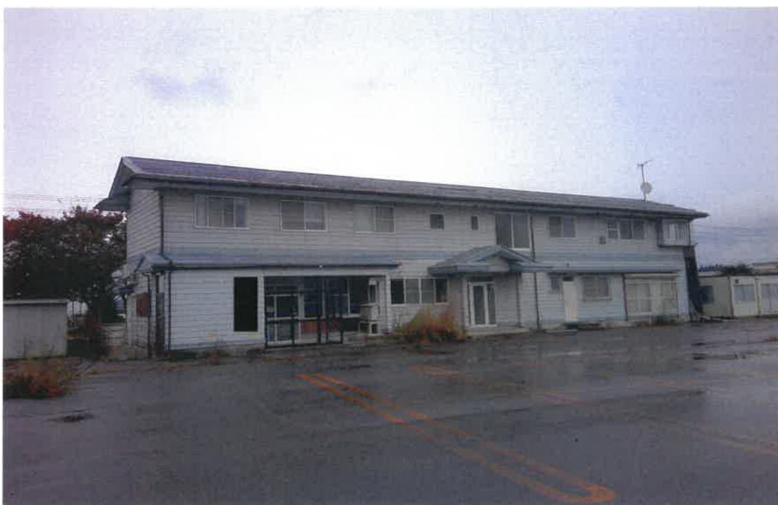
写真②(建物外観 物件14 附属建物)
