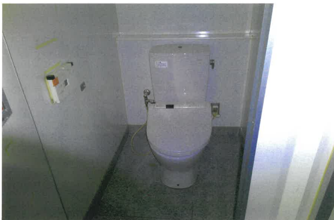
写真⑧(物件14 主とする建物 1階 遊技場トイレ)
