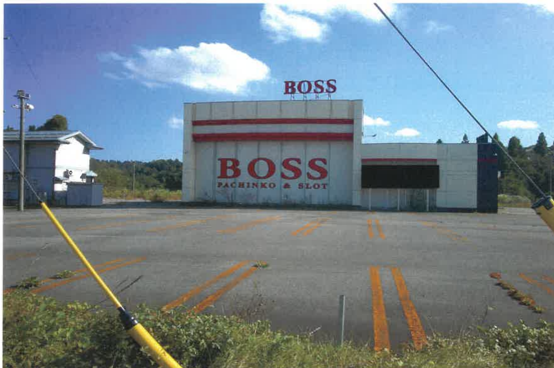
写真①(建物外観 物件14 建物外観写真 主とする建物)
