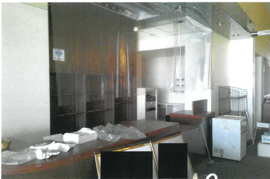
写真⑥(物件14 主とする建物 遊技場フロント付近)
