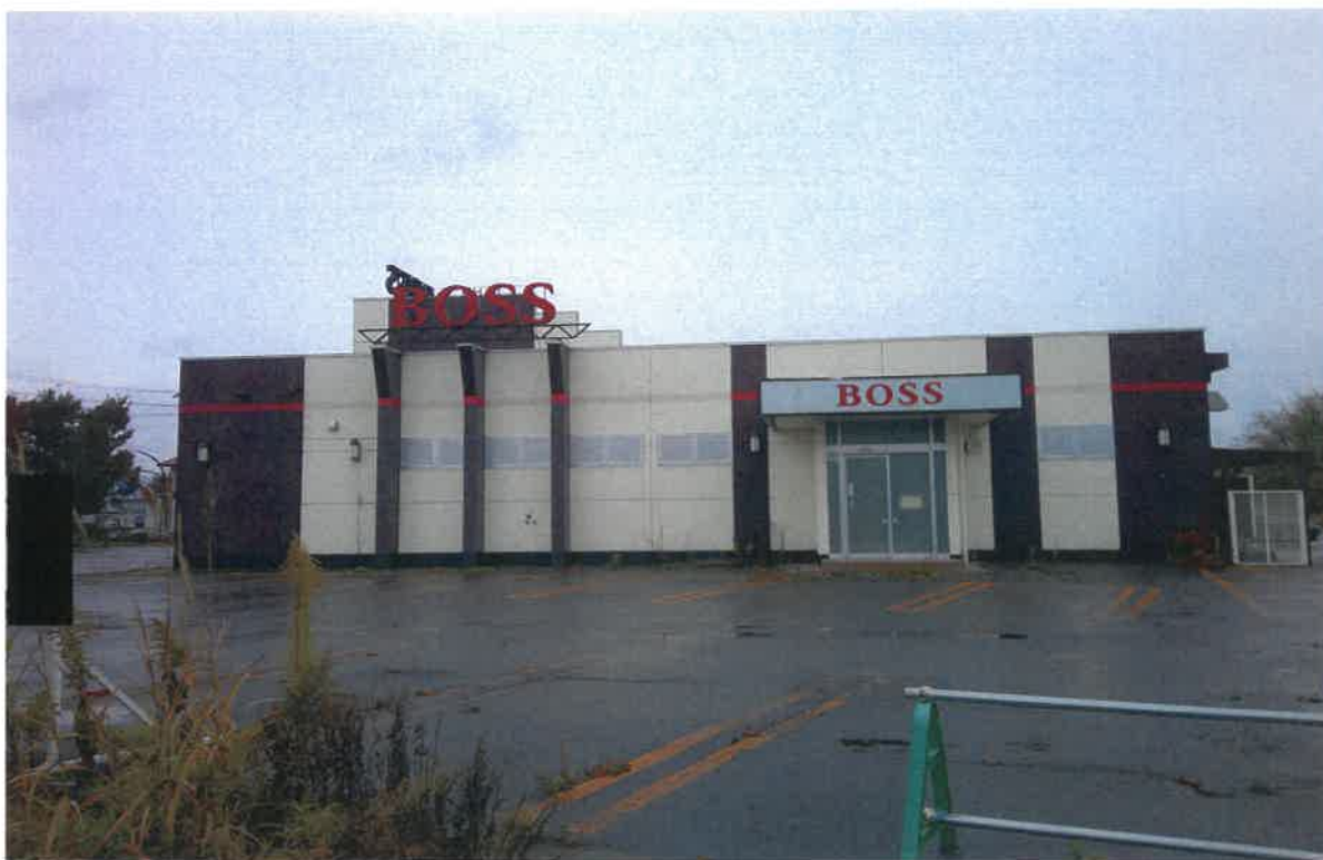
写真④(一体地 西側駐車場)
