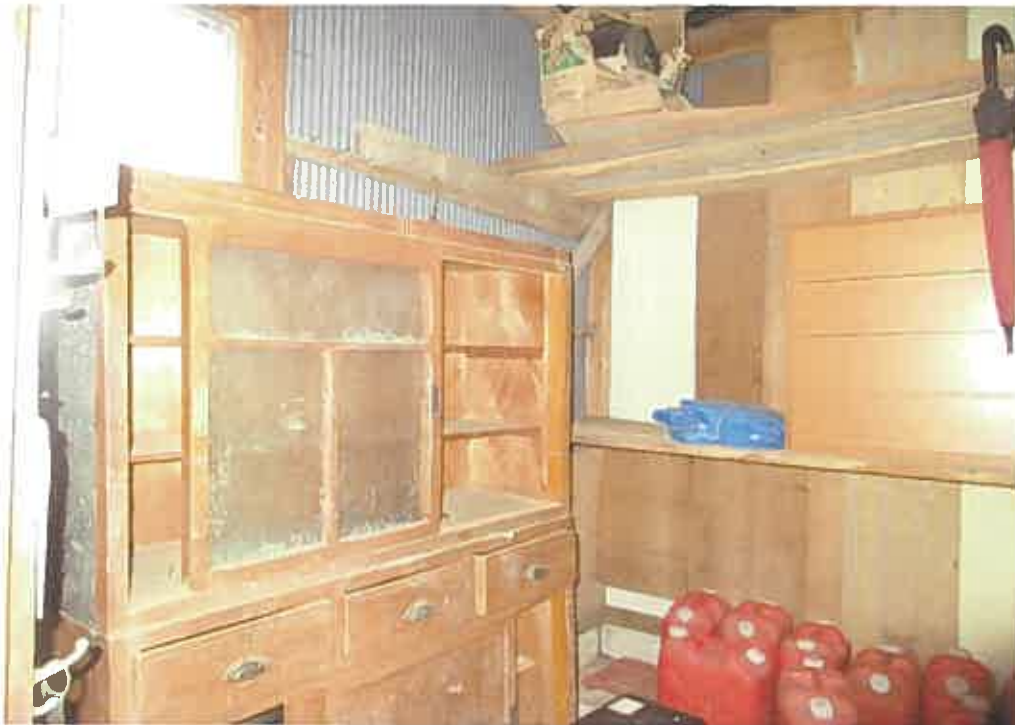
物件3附属建物符号1:内部の状況
