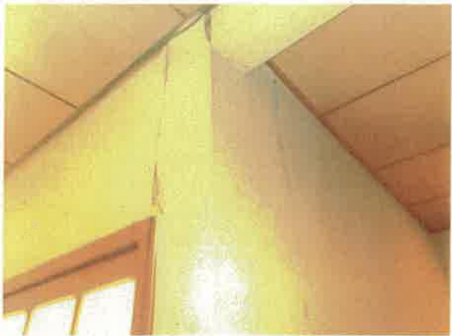
物件2:玄関に面した廊下の東側の状況
