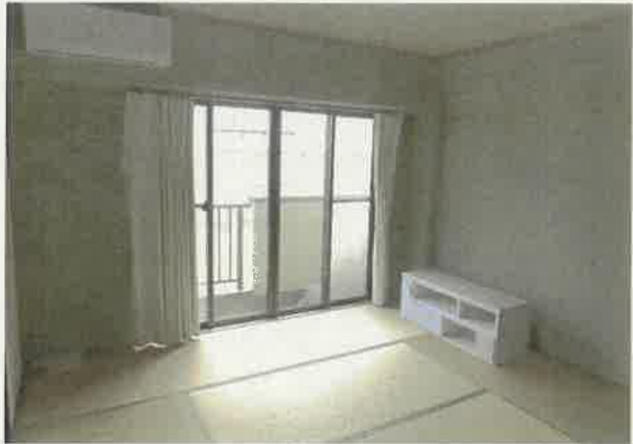
物件3主である建物:211号室南側和室の状況
