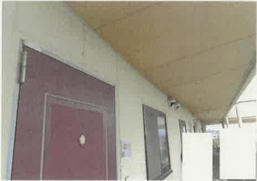
物件3主である建物:4階通路(413号室付近)の天井の状況
