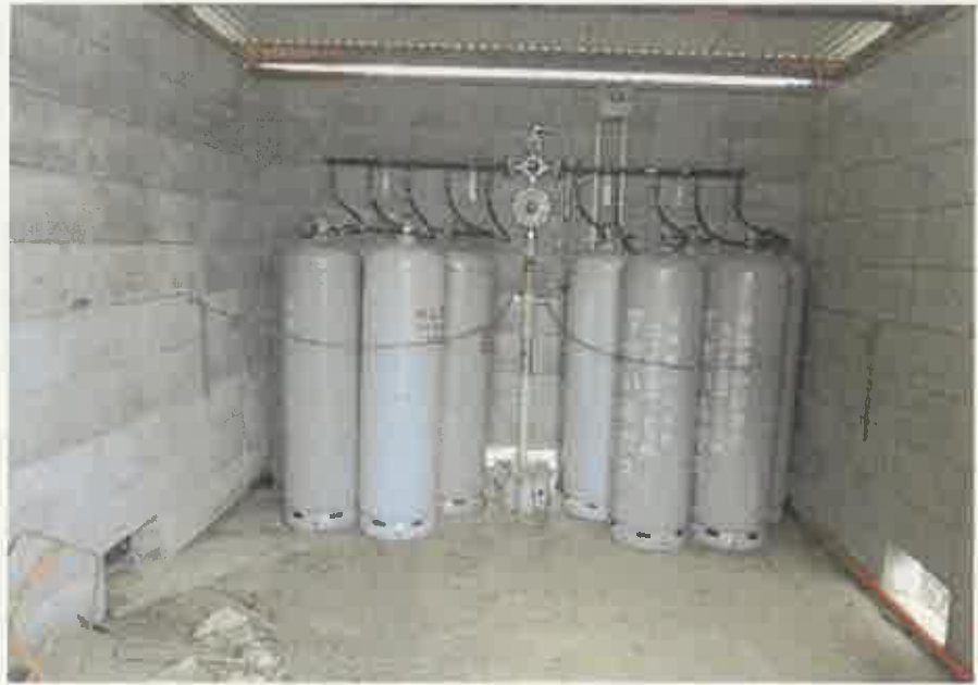
物件3附属建物符号3:内部の状況
