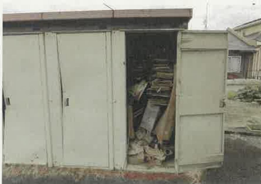
物件3附属建物符号2:内部の状況
