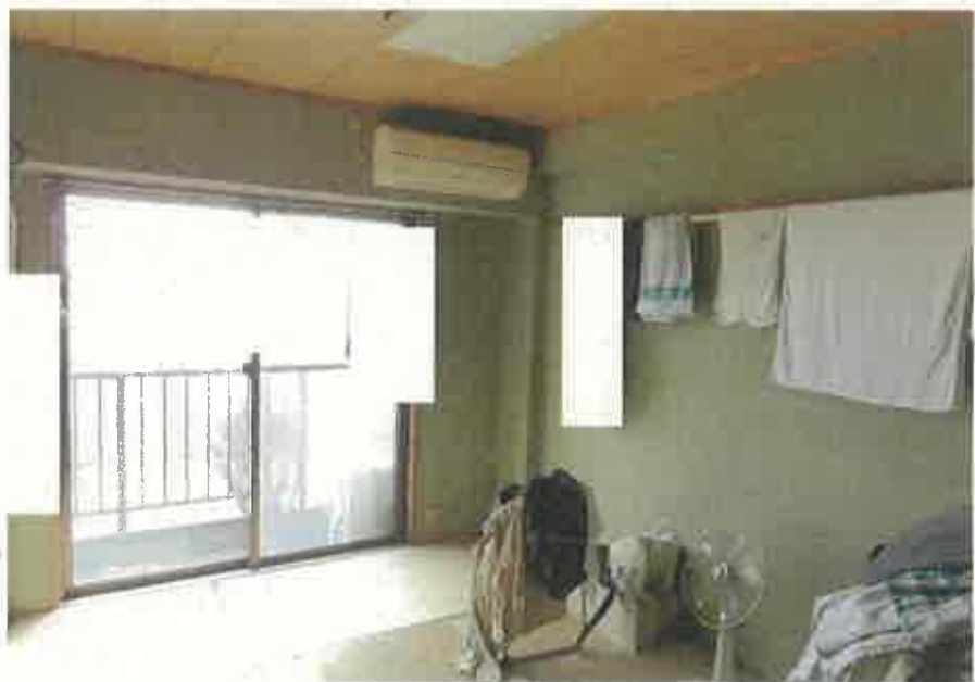
物件3主である建物:315号室南側和室の状況
