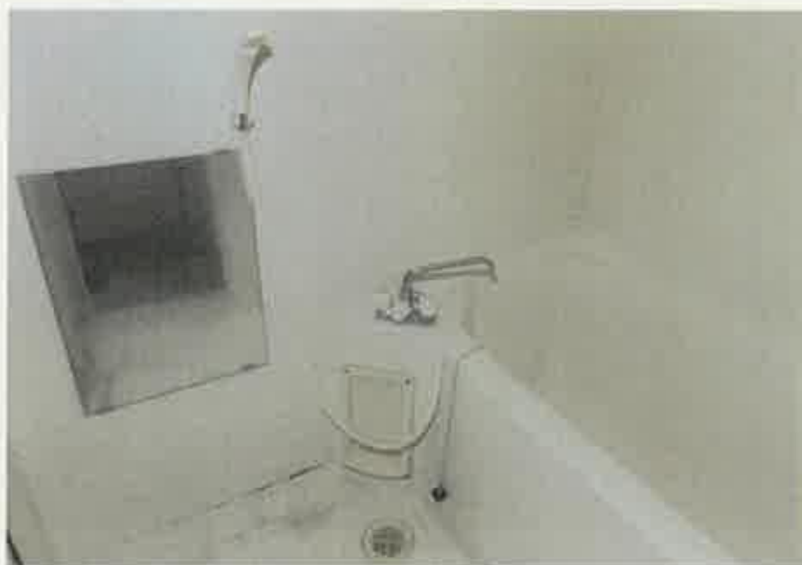
物件3主である建物:114号室浴室の状況
