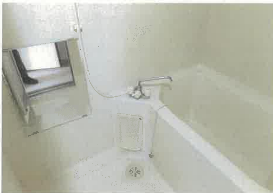
物件3主である建物:111号室浴室の状況
