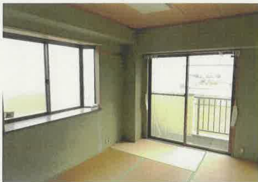
物件3主である建物:211号室北側和室状況
