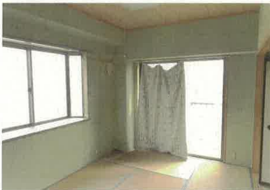
物件3主である建物: 111号室北側和室 の状況
