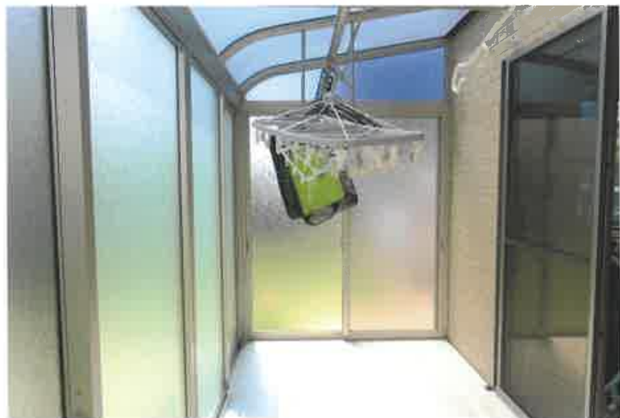
物件2:1階サンルームの状況
